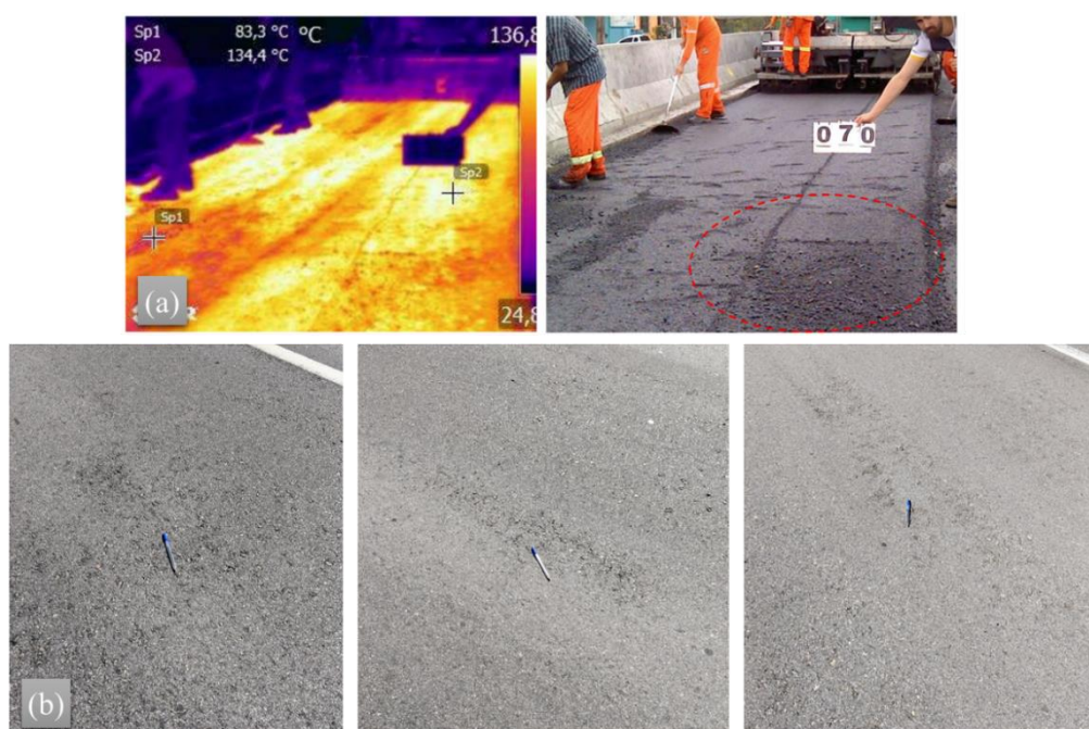
Figura 122 - Acabamento manual da superfície: (a) efeitos antes da compactação; (b) efeito visual nos segmentos experimentais da BR 116/RS
