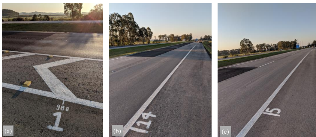
Figura 113 - Microrrevestimento aplicado nos trechos monitorados: (a) SEG03 estaca 1+00m; (b) SEG 02 estaca 14+10m; (c) SEG 01 estaca 5+00m
