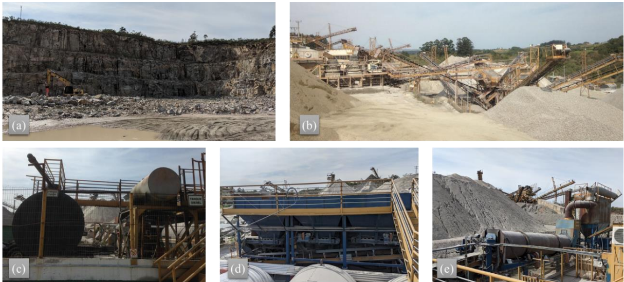
Figura 45 - Britagem MAC Engenharia: (a) painel de rochas; (b) britagem; (c) tanques de ligante; (d) silos para a usina de asfalto; (e) usina contínua
