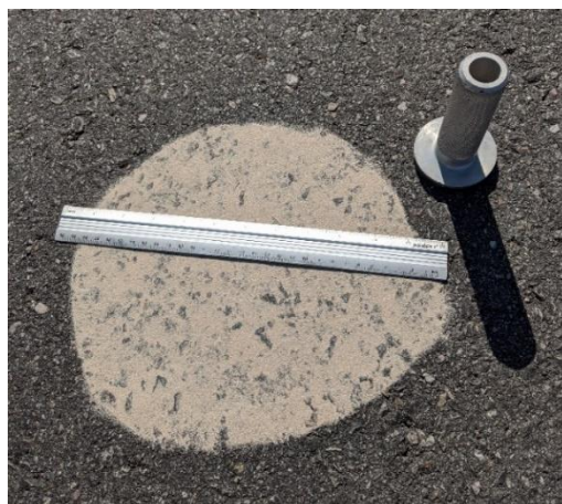
Figura 84 - Ensaio de mancha de areia
