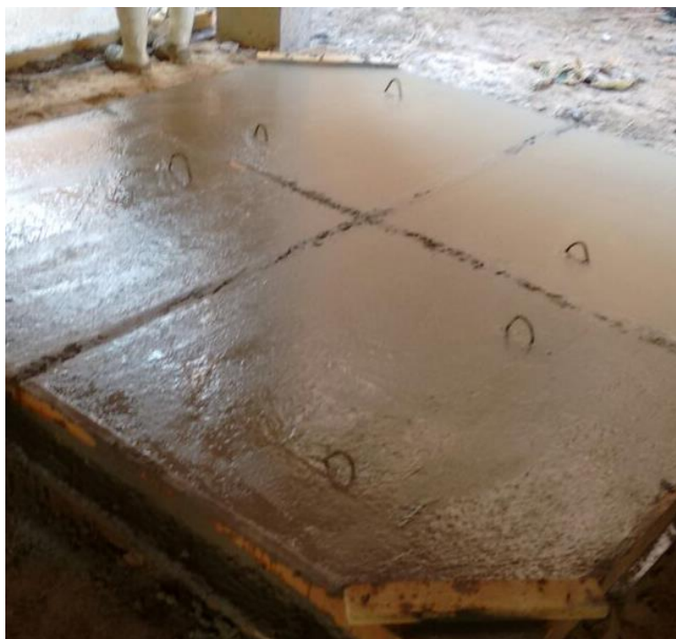
Figura 8 – Lajes no dia da concretagem
