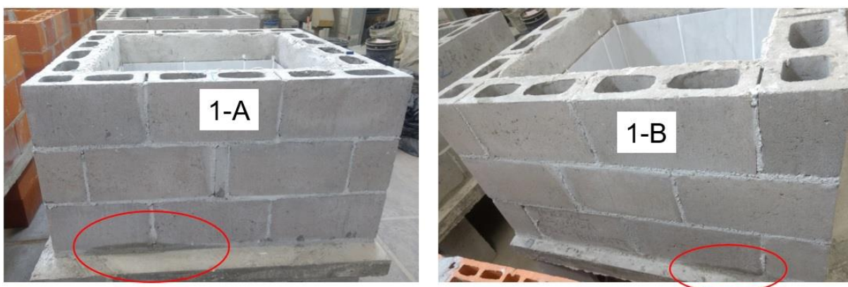
Figura 19 – Primeiras manchas de vazamentos nas faces externas da Caixa 1
