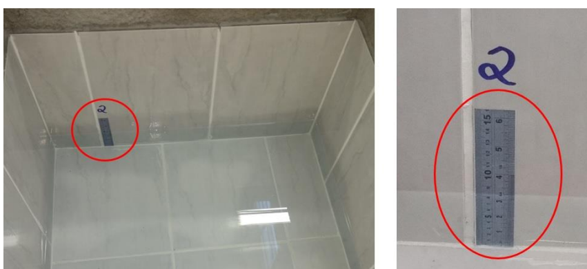
Figura 13 – Caixa com régua instalada
