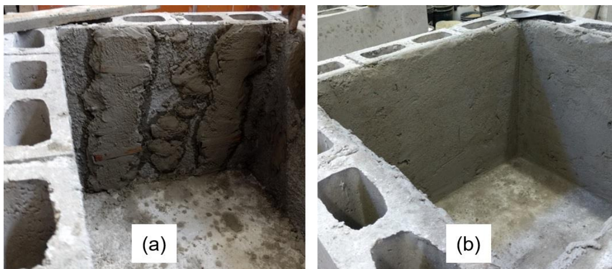
Figura 11 – Camada de emboço sendo executada (a), Caixa 1 finalizada (b)
