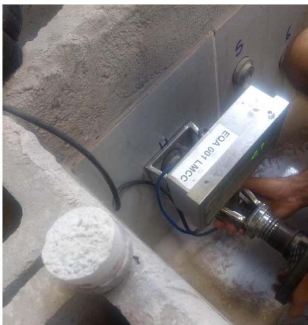
Figura 17 – Ensaio de resistência à tração sendo executado na Caixa 1
