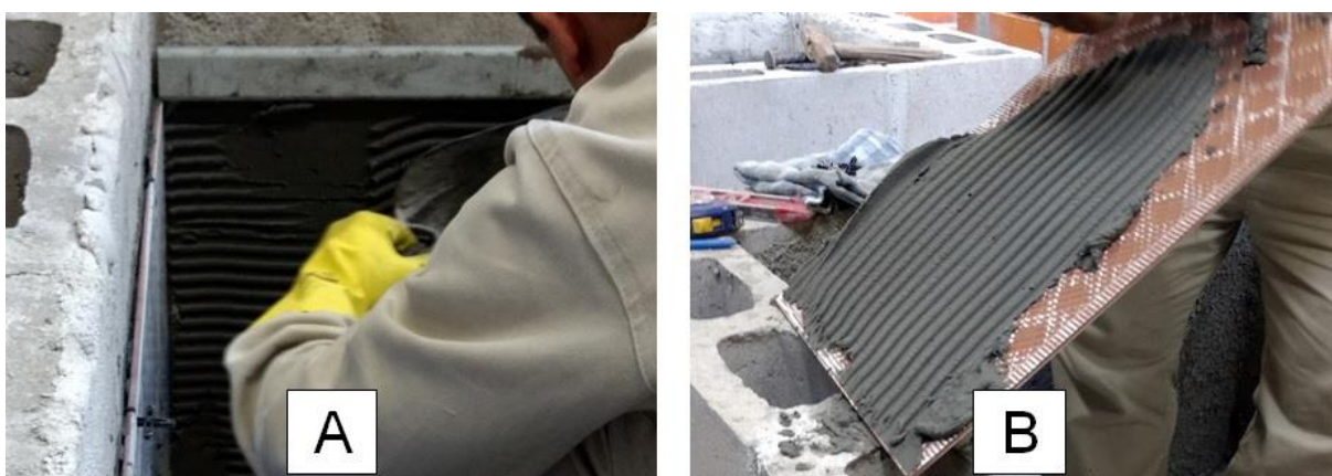
Figura 12 – Aplicação da argamassa colante no substrato (a) e no tardoz (b)
