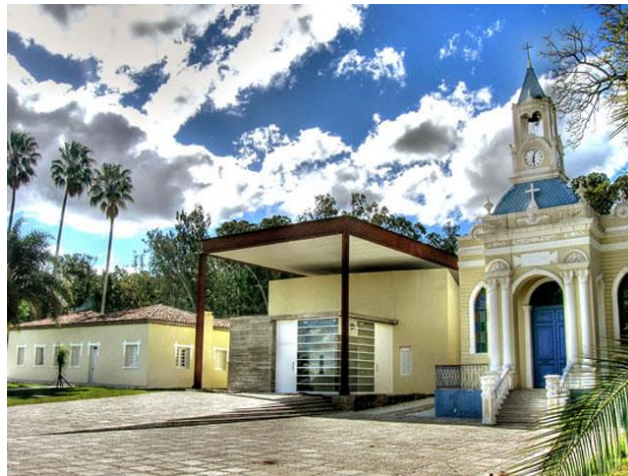
Figura 11 - Área revitalizada do Centro Histórico Vila de Santa Thereza, memorial, capela e teatro
