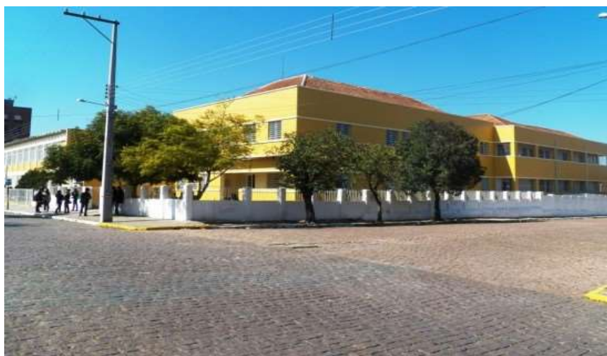
Imagem 10- fachada da escola.
