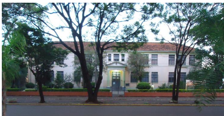
Figura 23 – Prédio do Colégio Onofre Pires em 2018
