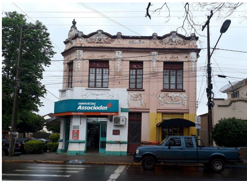
Figura 17 – Prédio da Farmácia Licht em 2018
