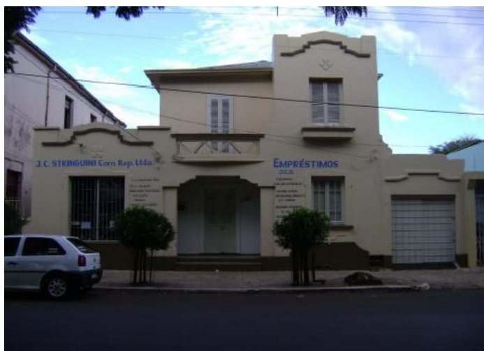
Figura 19 – Prédio do Escritório de Representação em 2018
