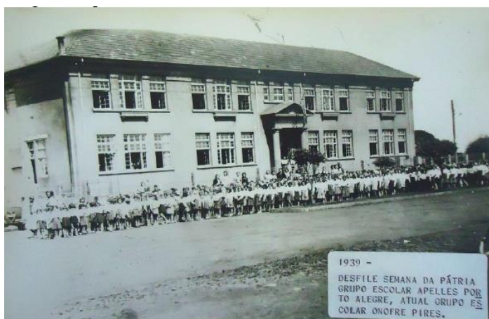
Figura 22 – Prédio do Colégio Onofre Pires em 1939
