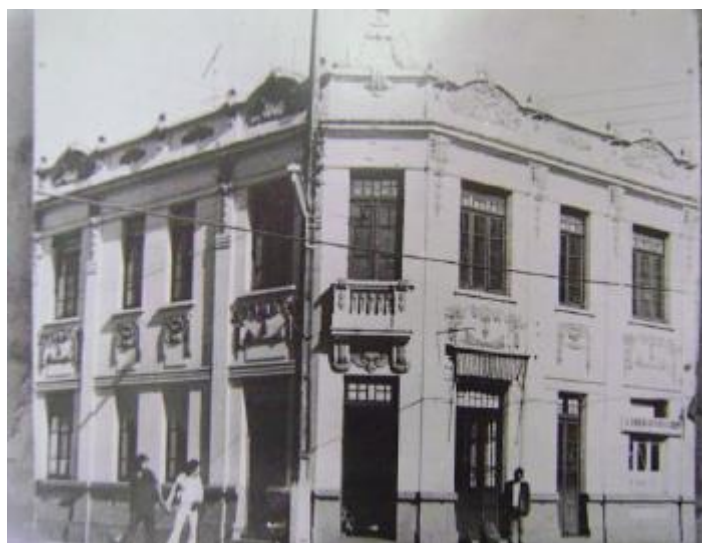
Figura 16 – Prédio da Farmácia Licht finalizado em meados de 1926
