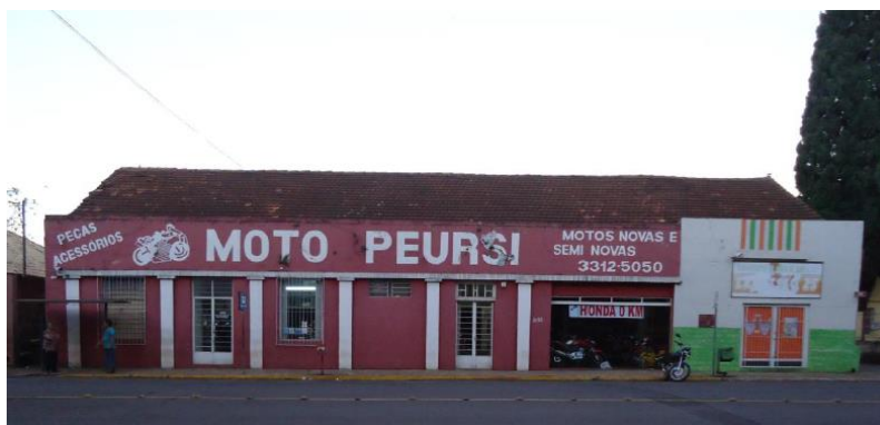
Figura 26 – Prédio da Moto Peursi em 2018
