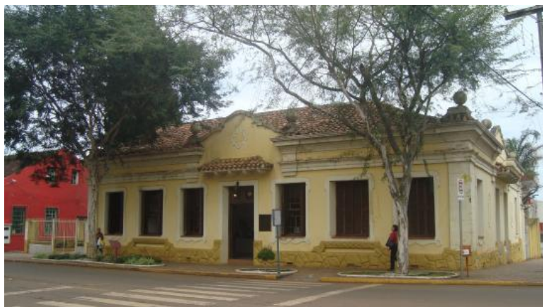
Figura 28 – Prédio do museu em 2018
