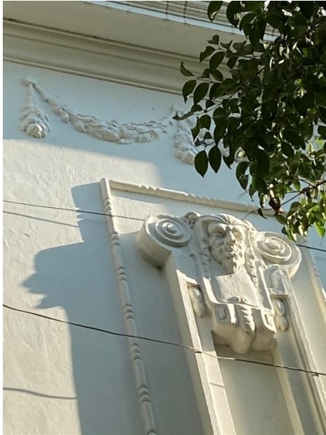
Figura 50: Decoração da fachada
