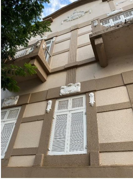
Figura 24: Detalhes da fachada
