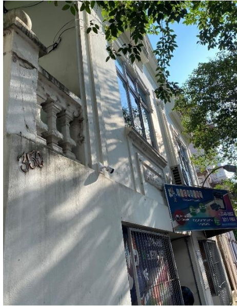
Figura 45: Vista lateral da fachada
