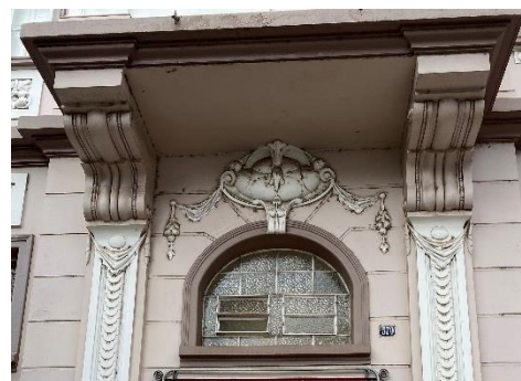
Figura 61: Consolos da sacada
