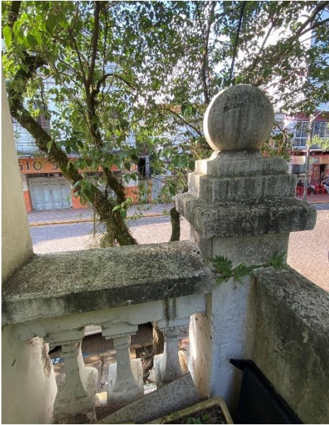
Figura 44: Ornamentos da fachada
