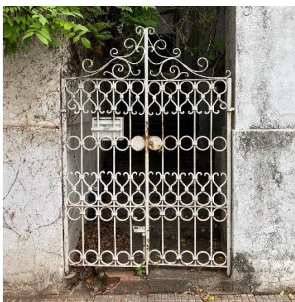
Figura 40: Portão de ferro original
