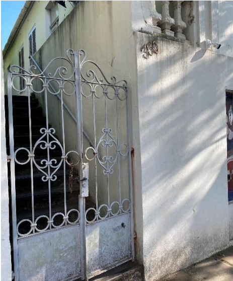
Figura 46: Portão de acesso principal
