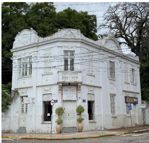
Figura 34: Fachada – Rua Júlio de Castilhos e Borges de Medeiros
