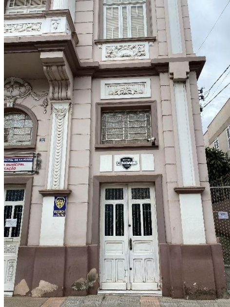
Figura 57: Composição da fachada
