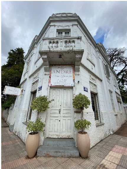
Figura 36: Vista da esquina
