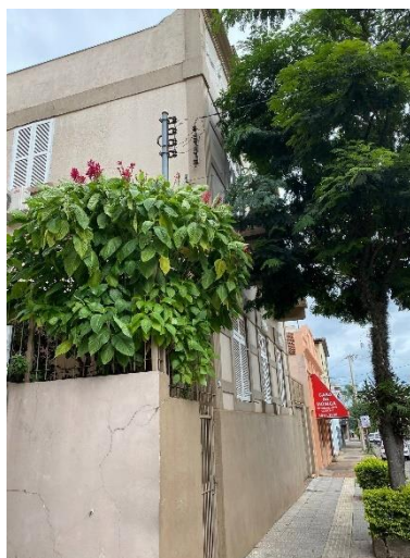
Figura 23: Vista da fachada lateral esquerda
