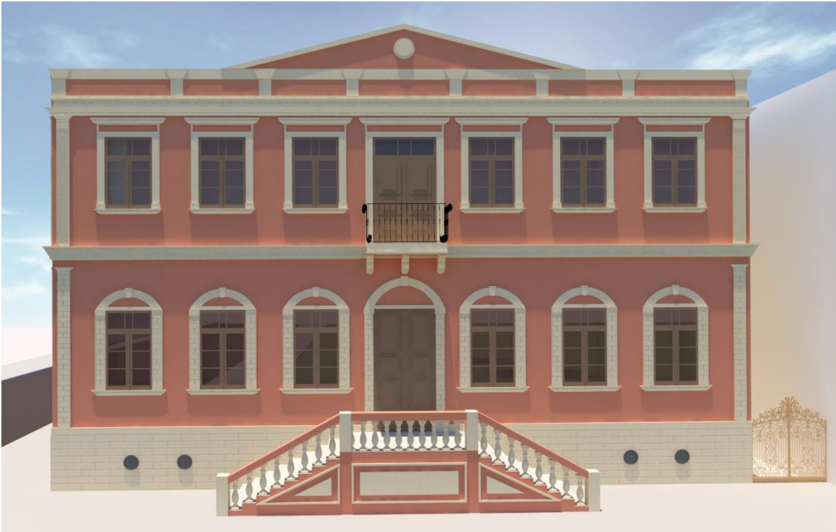
Figura 63 – Fachada da Casa de Cultura
