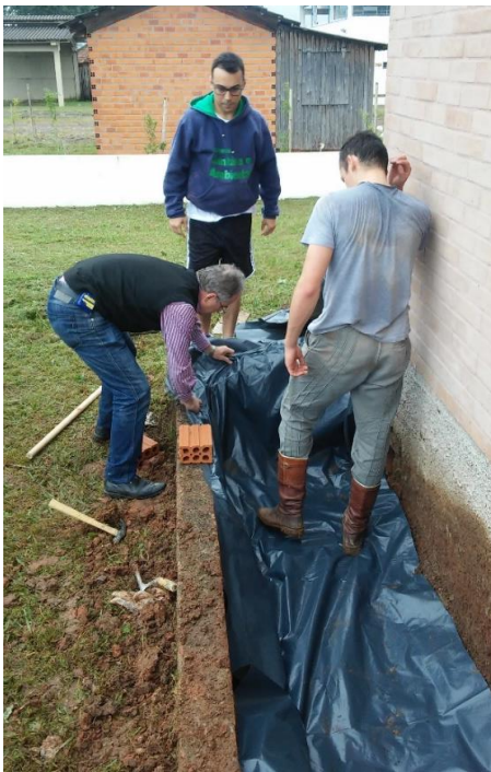
Figura 3.14: Colocação de lona duplicada no fundo do coletor solar.
