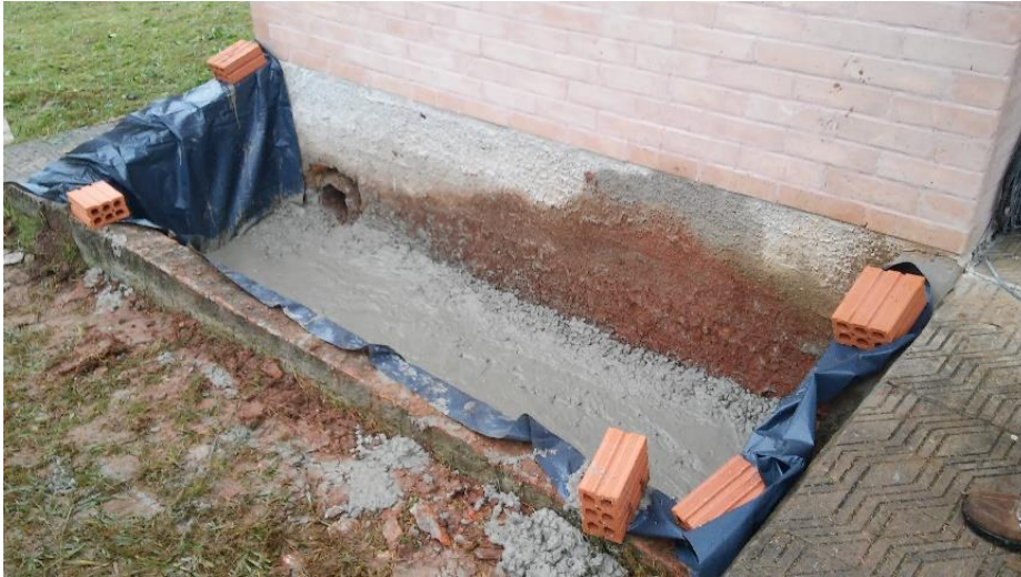
Figura 3.15: Coletor solar com lona e contrapiso feitos.
