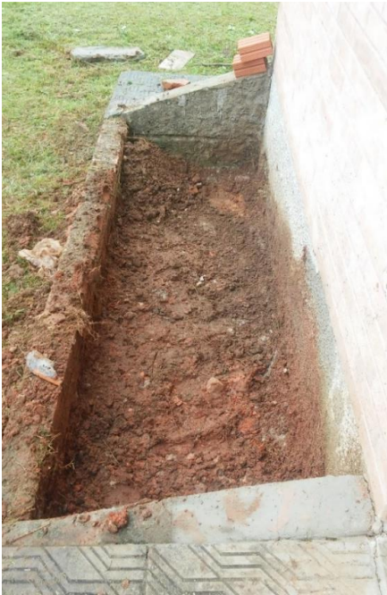
Figura 3.13: Coletor solar após a retirada da carga de terra.
