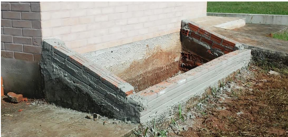
Figura 3.16: Coletor Solar acrescentadas duas fiadas de tijolos.
