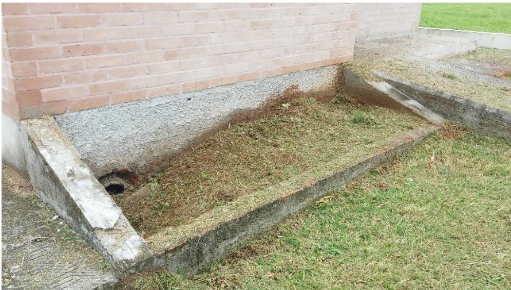
Figura 3.12: Local onde foi construído o SSPAA, depois de limpeza feita pela SulClean.
