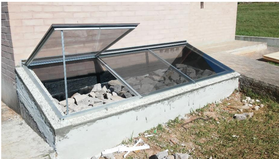
Figura 3.20: Coletor Solar com execução concluída.
