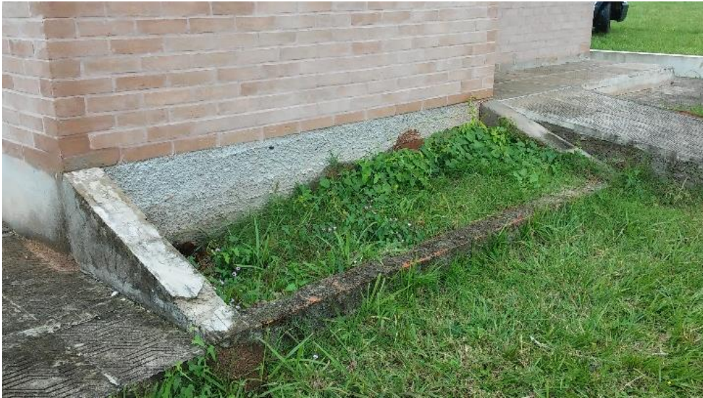
Figura 3.11: Local onde foi construído o SSPAA, antes das intervenções.
