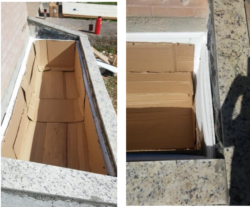
Figura 3.17: Detalhe das camadas de isopor e papelão.
