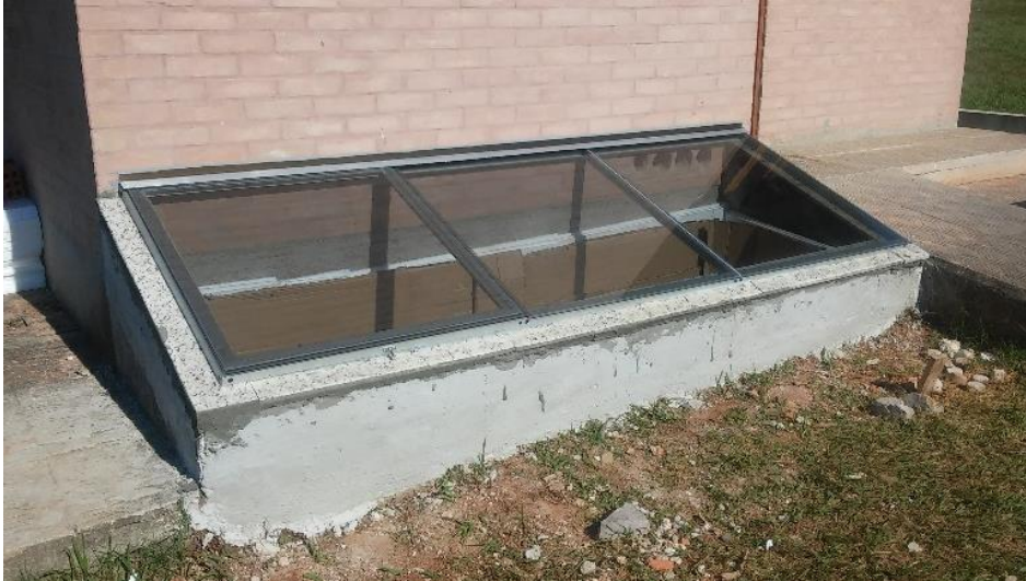
Figura 3.19: Coletor solar após a instalação de esquadria de alumínio e vidro simples 4mm.
