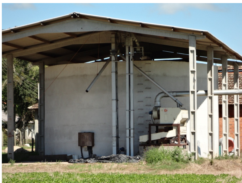
Figura 1 – Silo secador de alvenaria
