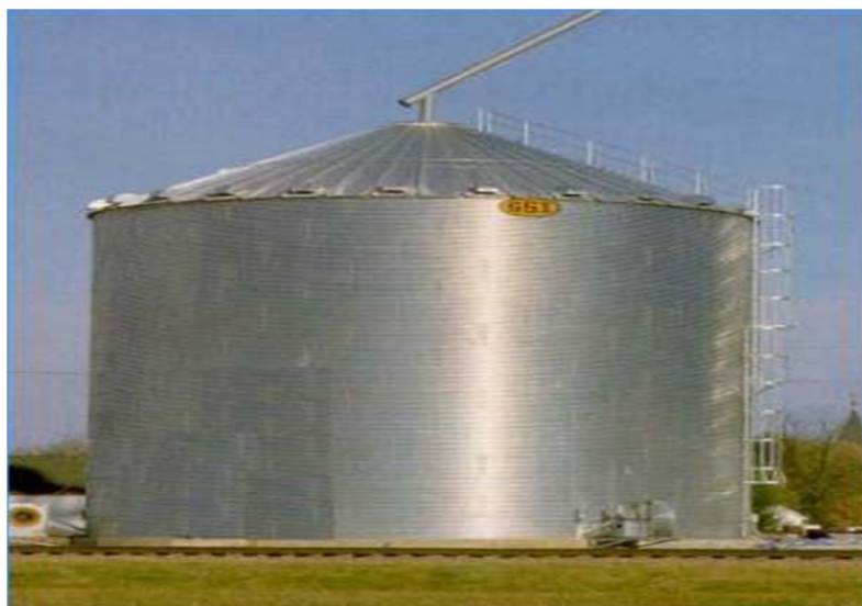
Figura 2 – Silo secador metálico
