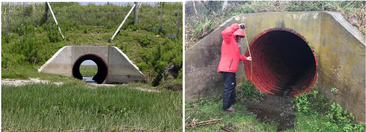
Figura 8 - Túnel para passagem de animais.
