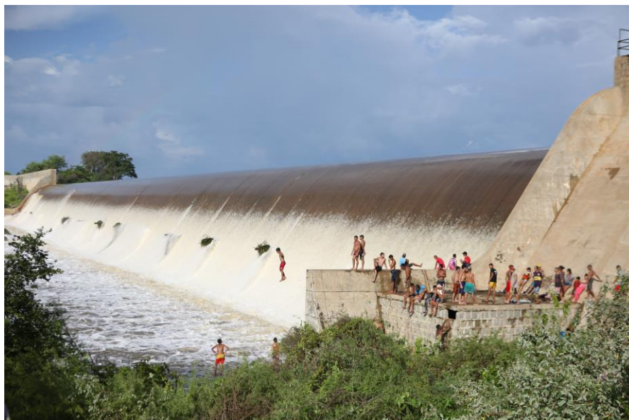
Figura 21 - Vista da Barragem de Brotas
