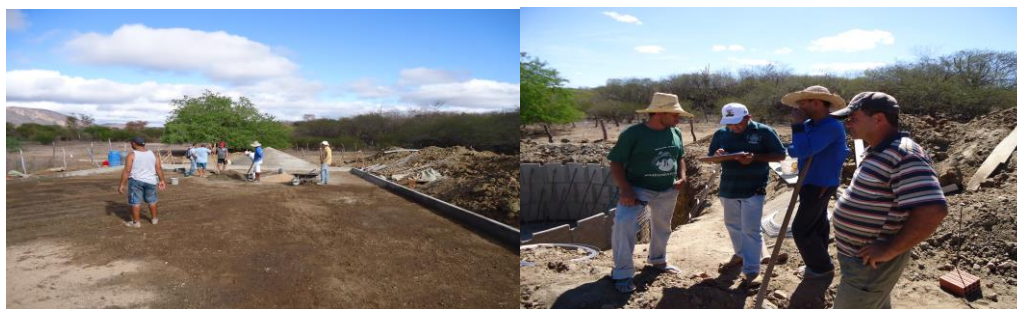
Figura 35 - Construção de cisternas de forma coletiva e participativa pelas famílias
