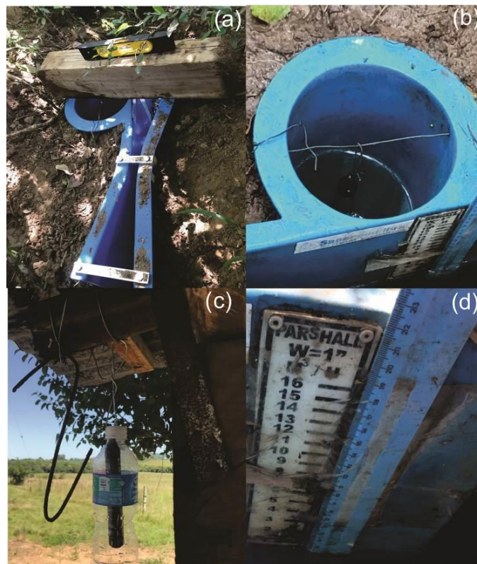
Figura 4.2 – (a) Implantação da Calha Parshall, (b) poço comunicante com sensor de nível, (c) barologger e (d) régua graduada em centímetros
