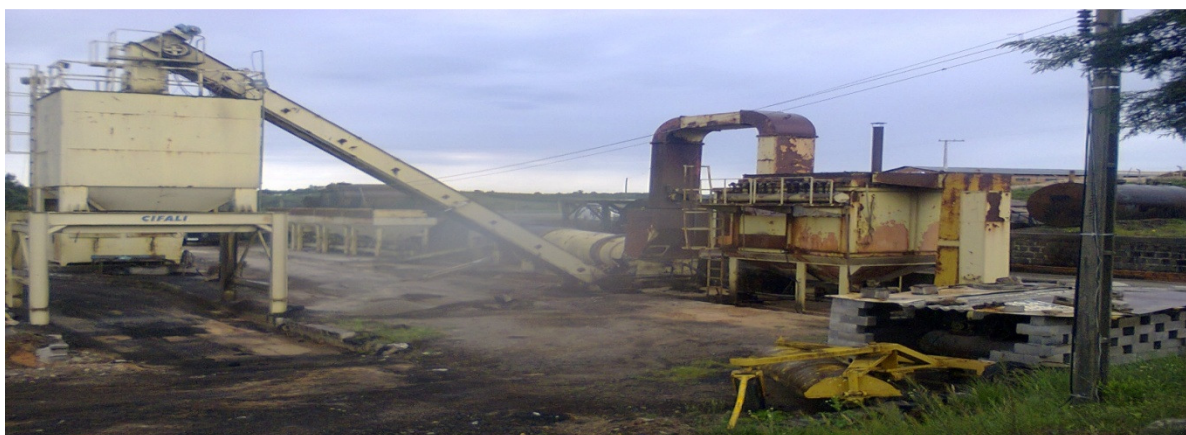
Figura 1- Imagem geral da Usina de Asfalto de Santa Maria/RS
