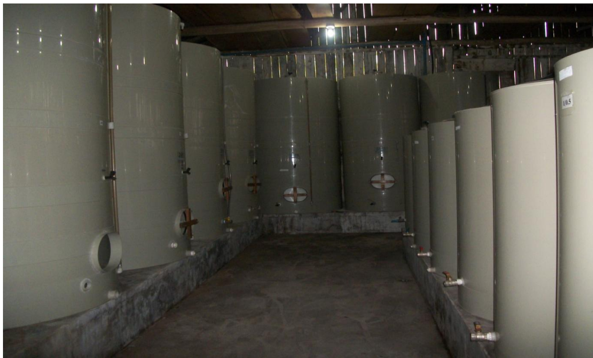
Figura 9 - Pipas de vinificação da propriedade rural do município de Dilermando de Aguiar/RS
