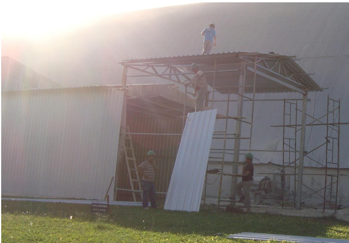
Figura 20- Armazém em reforma
