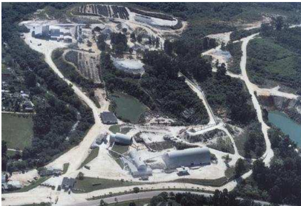
Figura 1 - Vista superior do parque industrial
