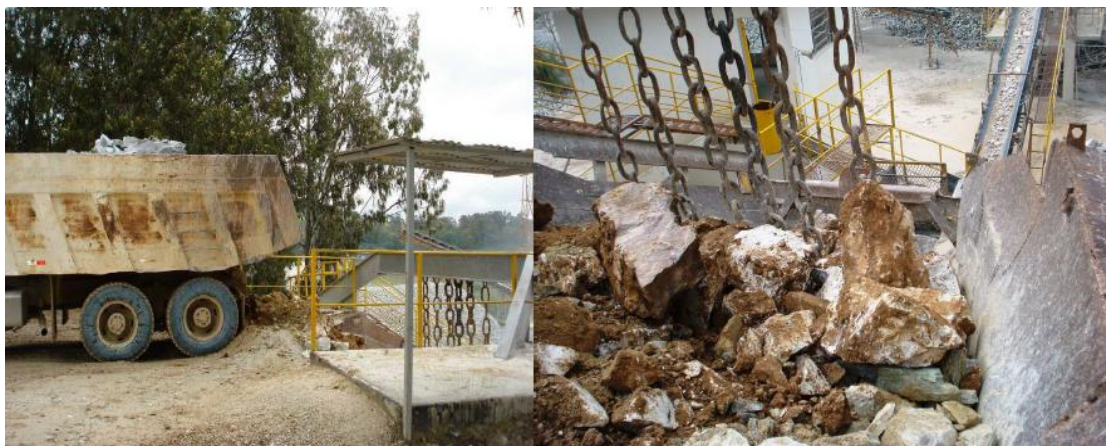
Figura 4 - Recepção das pedras – descarregamento (esquerda) e tremonha (direita).
