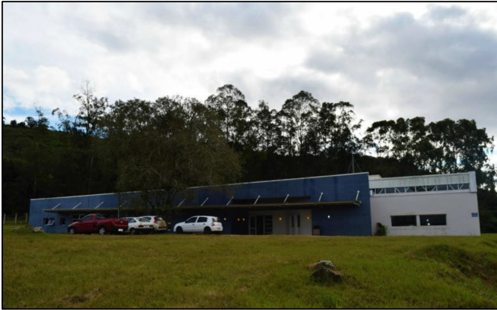
Figura 04 - Prédio CONDESUS/CAPPA em São João do Polêsine/RS
