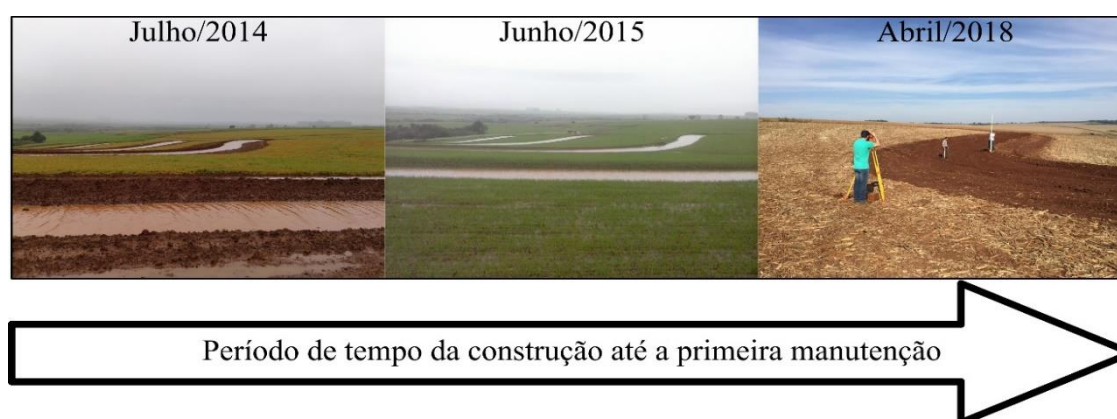
Figura 8 – Evolução temporal da construção, da acomodação e da reconstrução dos terraços
