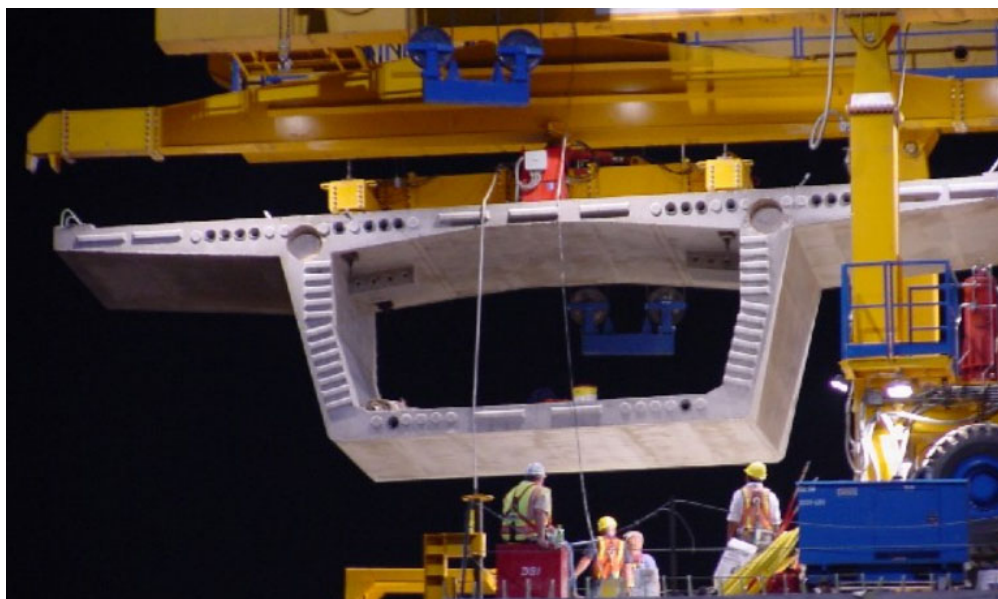
Figura 2.6 – Aduela pré-moldada padrão empregada no sistema construtivo de balanços sucessivos.
