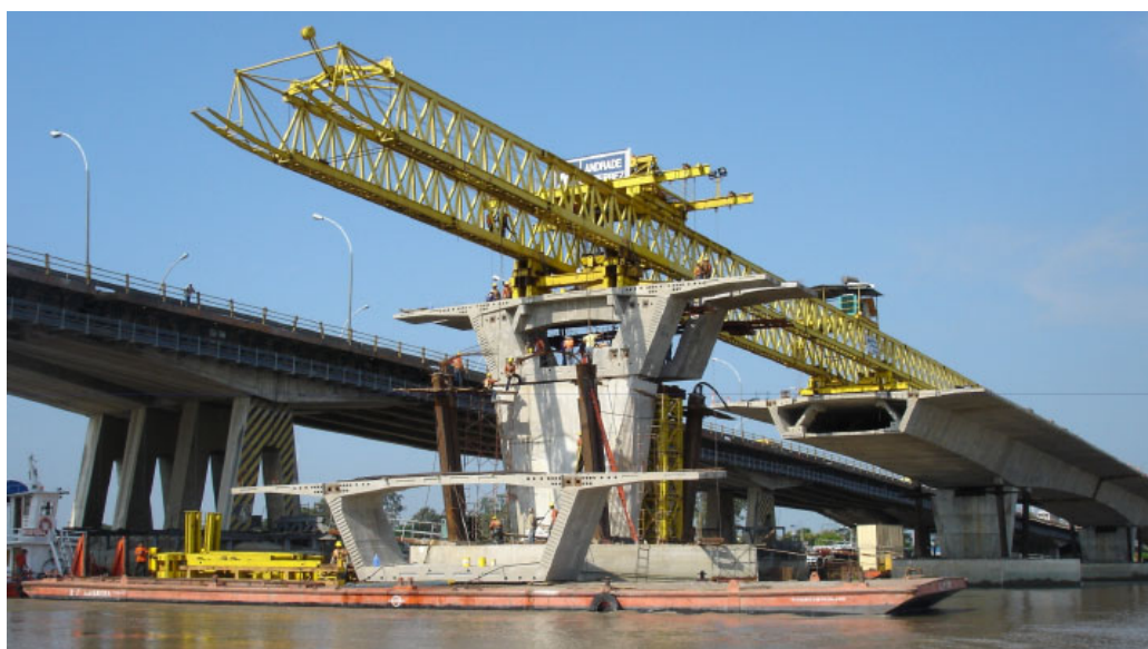
Figura 2.5 – Posicionamento de aduelas pré-moldadas por meio de treliça de lançamento.
