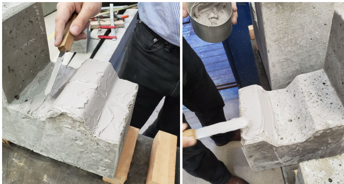
Figura 4.11 – Aplicação do adesivo epóxi nas duas partes pré-moldadas das juntas.
