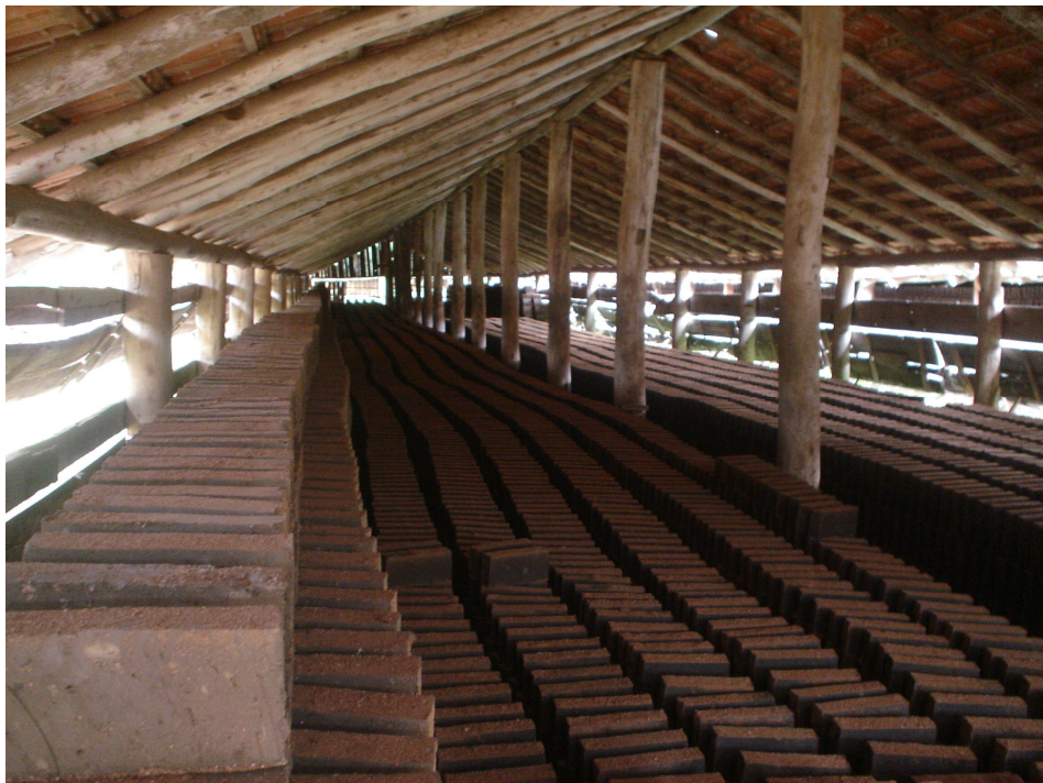
Figura 15 – Galpão de secagem
