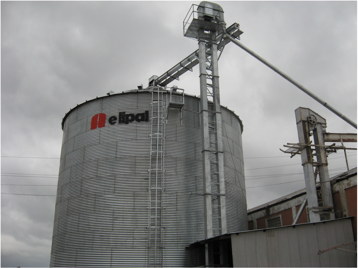
Figura 1 – Silo de estocagem de arroz em casca
