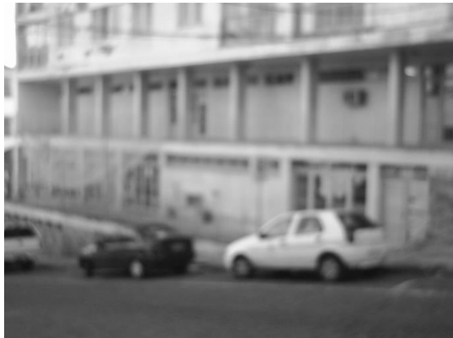
Figura 6 - foto externa do imóvel da rua Tuiuti,
