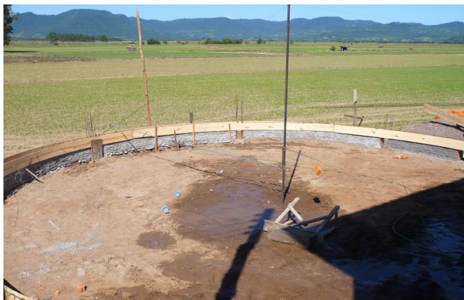
**Figura 1 – Base do silo-secador de alvenaria**
