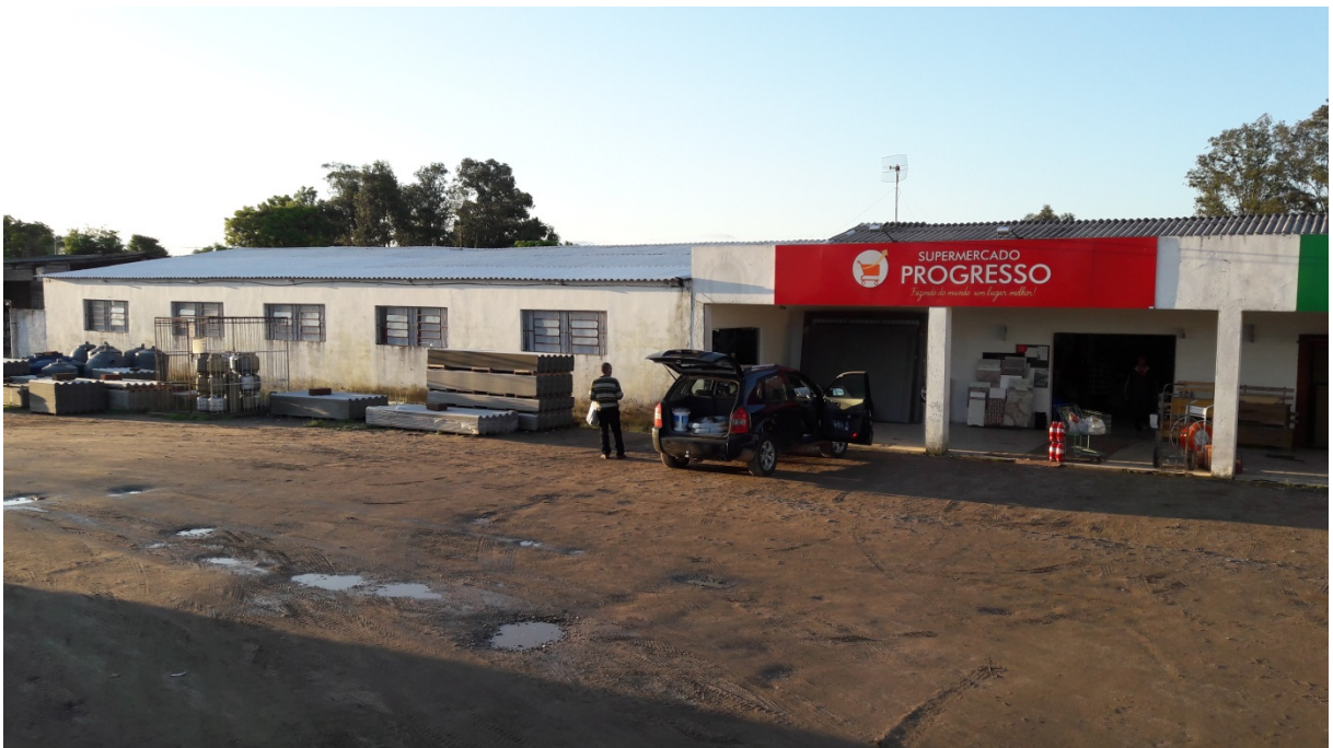
Figura 1 - Fachada da empresa
