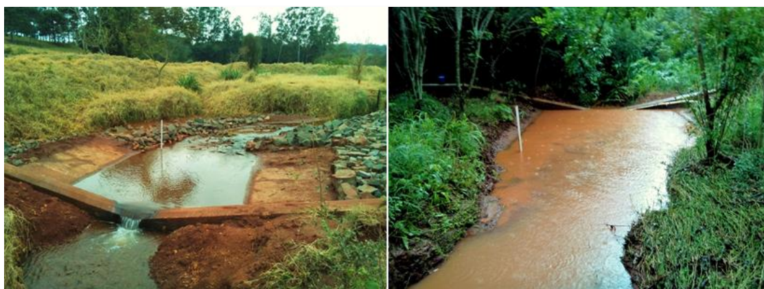
Figura 3: Vertedouro da bacia norte (direita) e vertedouro da bacia sul (esquerda), durante um evento de chuva (esquerda).
