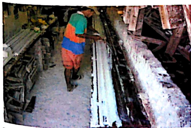
Foto 3 - Funcionário arrastando a forma sobre o gesso
