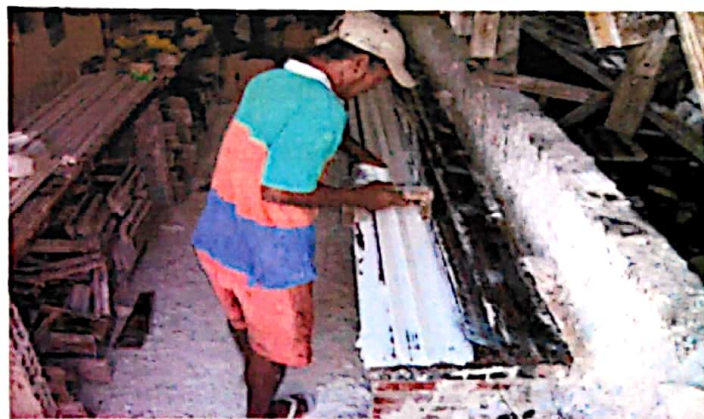
Foto 2 - Funcionário arrastando a forma sobre o gesso
