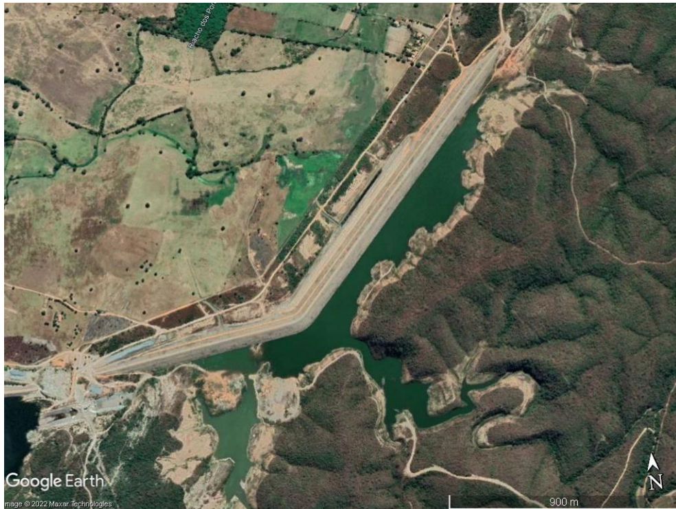
Figura 34 – Imagem via satélite da Barragem Cana Brava em julho de 2021.
