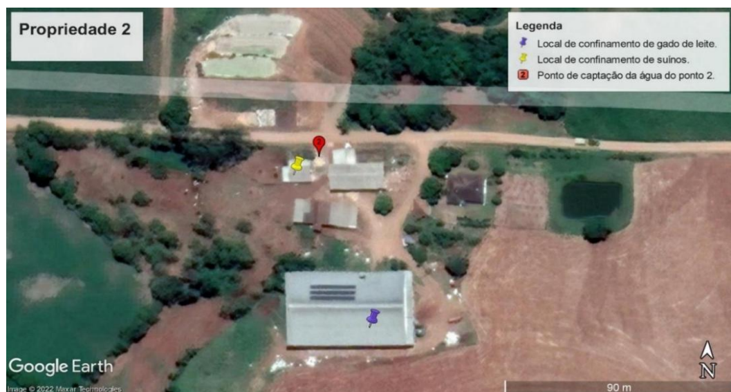
Figura 7 – Vista aérea da Propriedade 2.
