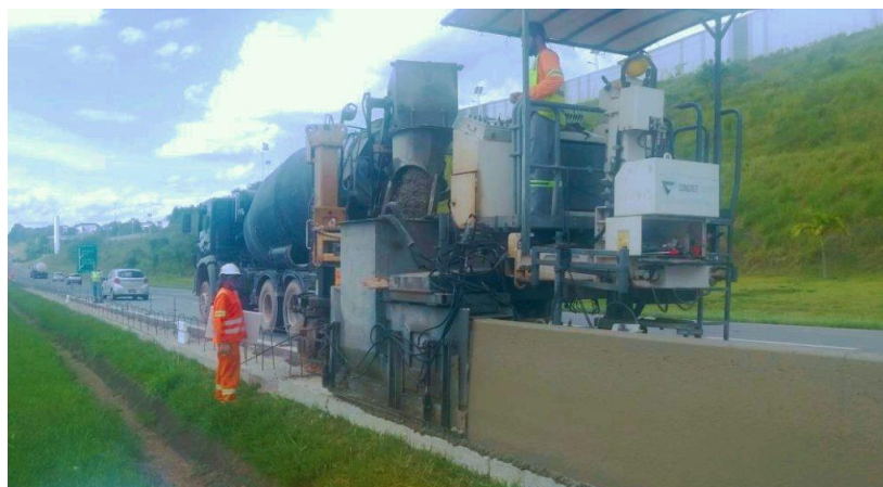
Figura 24 – Processo de extrusão contínua
