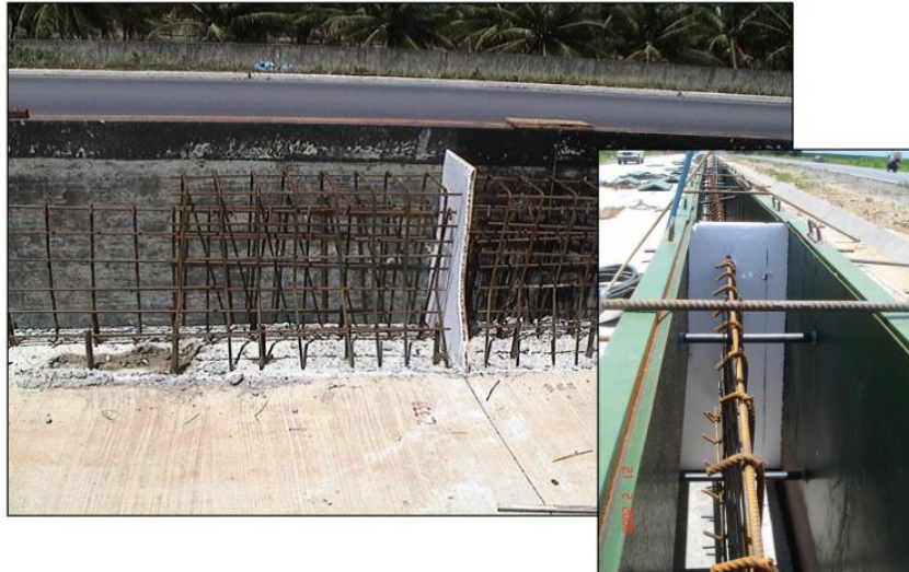
Figura 27 – Junta de dilatação
