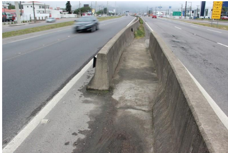
Figura 20 – Abertura para pedestres
