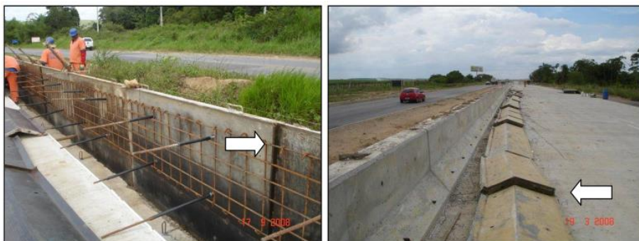
Figura 26 – Junta de retração
