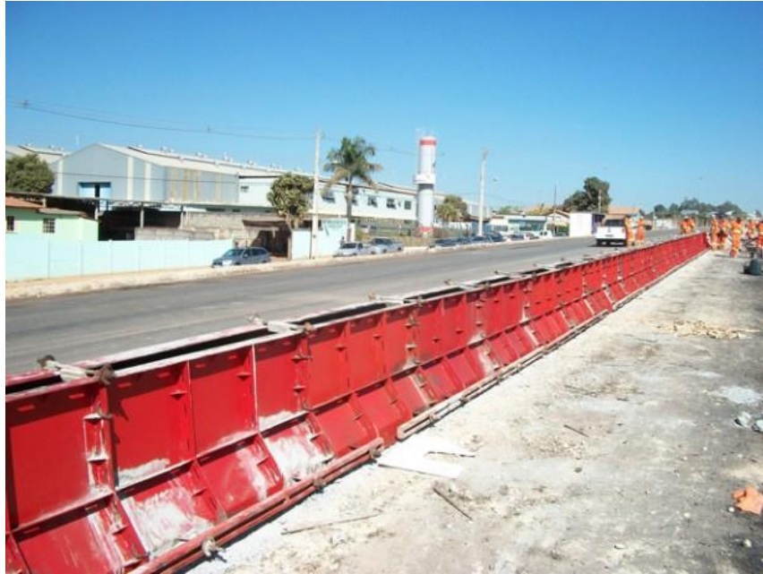
Figura 23 – Formas para moldagem in loco
