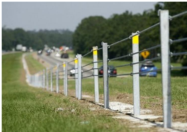
Figura 1 – Barreira de cabos de alta tensão
