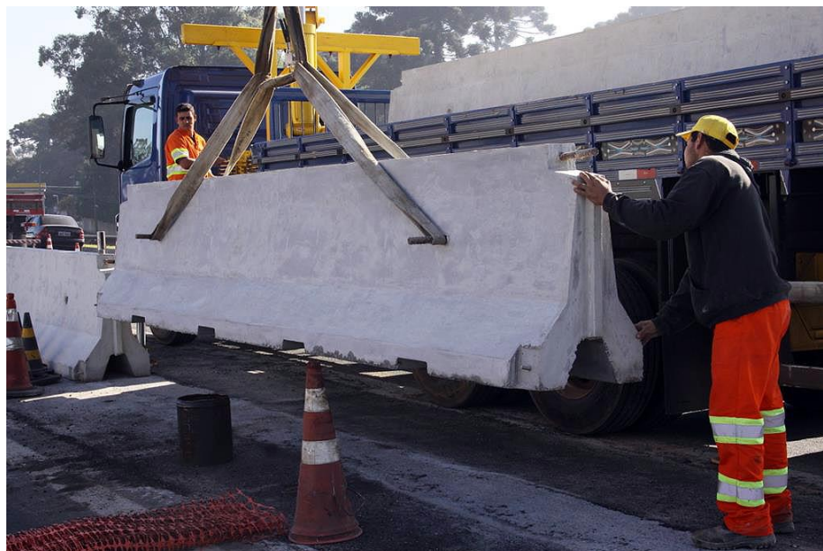
Figura 6 – Processo de instalação de barreiras pré-fabricadas
