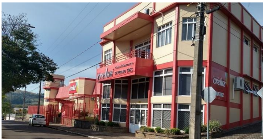
Figura 7 - Vista frontal da empresa CRELUZ localizada no município de Pinhal – RS.
