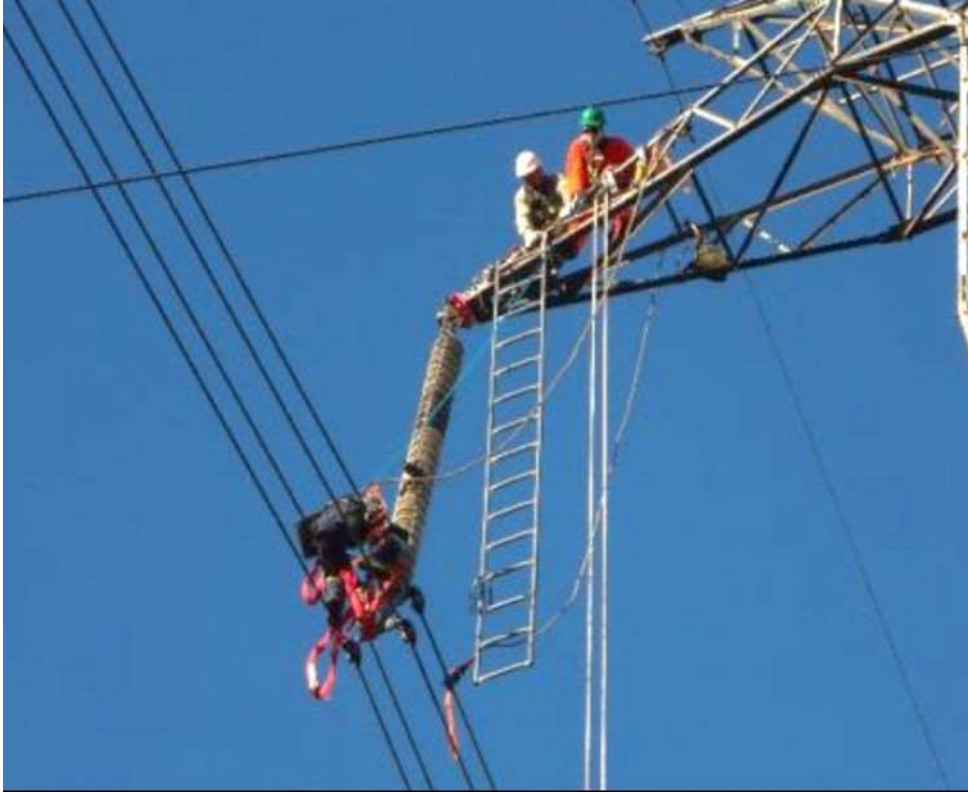
Figura 4.3 – Isoladores de vidro sendo retirados da linha
