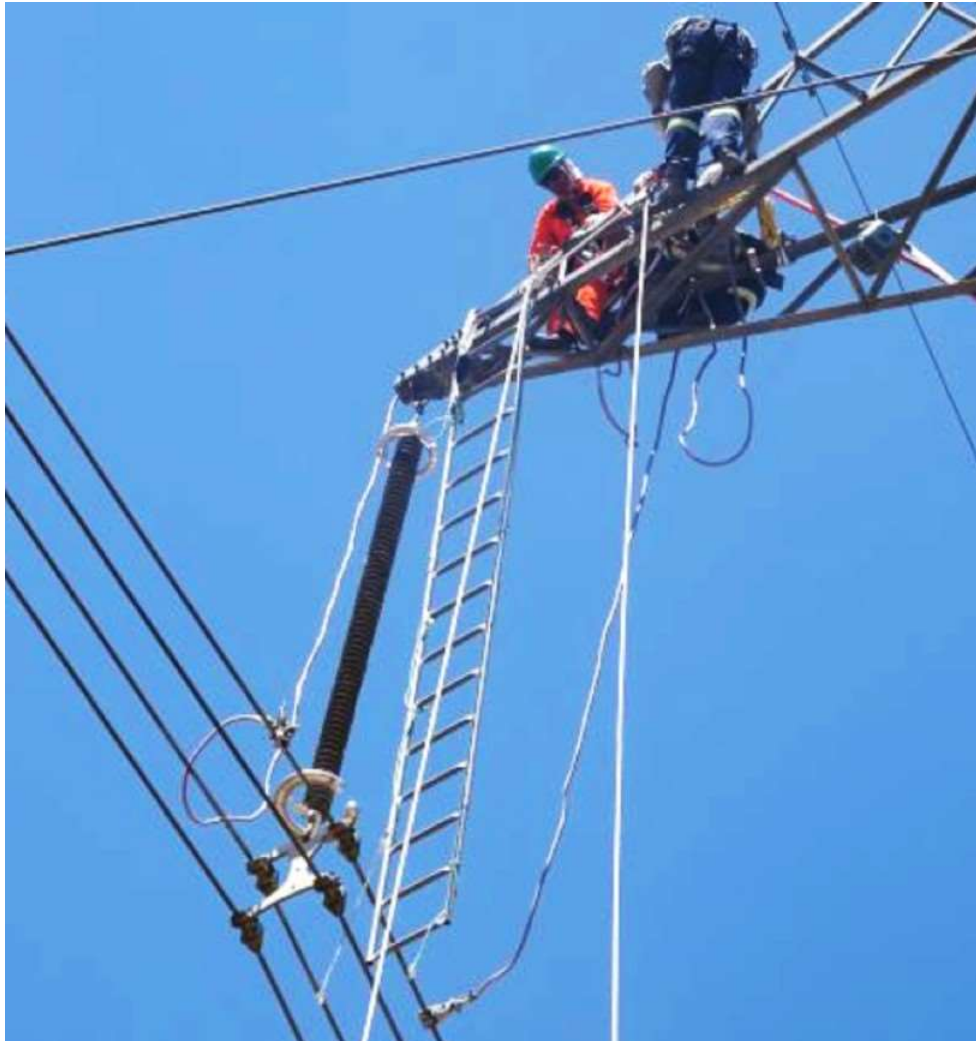
Figura 4.4 – Isoladores poliméricos sendo instalados na linha de transmissão
