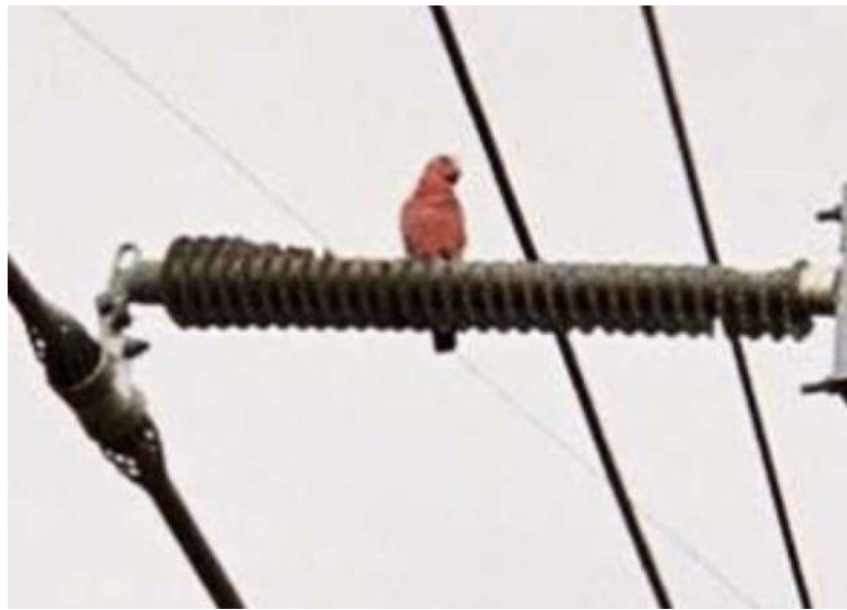
Figura 3.17 – Dano de pássaro em isoladores poliméricos de uma linha de 110 kV
