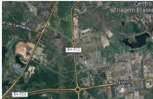
Figura 5 – Vista superior do terreno onde a unidade industrial poderá ser instalada.
