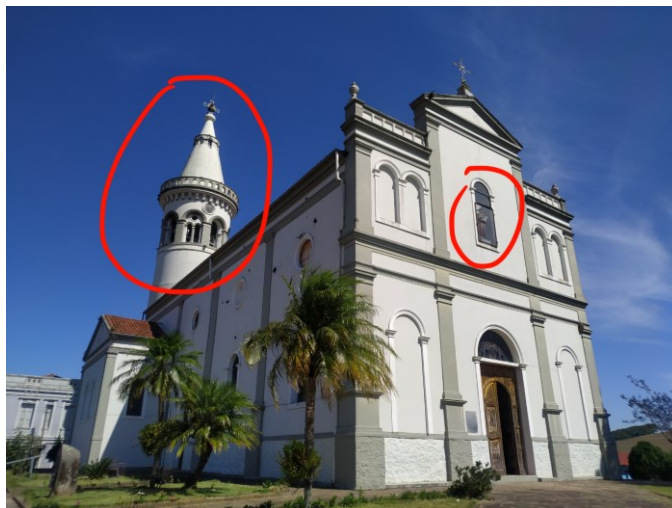
Figura 79 - Análise da fachada da matriz.
