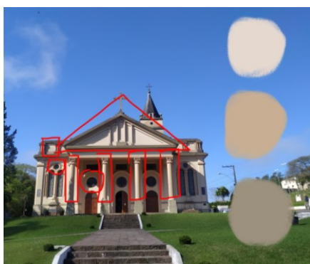
Figura 116 - Análise da fachada da matriz.
