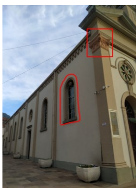
Figura 129 - Análise de detalhes da fachada da matriz.
