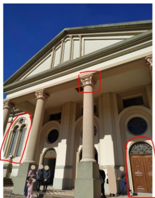
Figura 117 - Análise da fachada da matriz.
