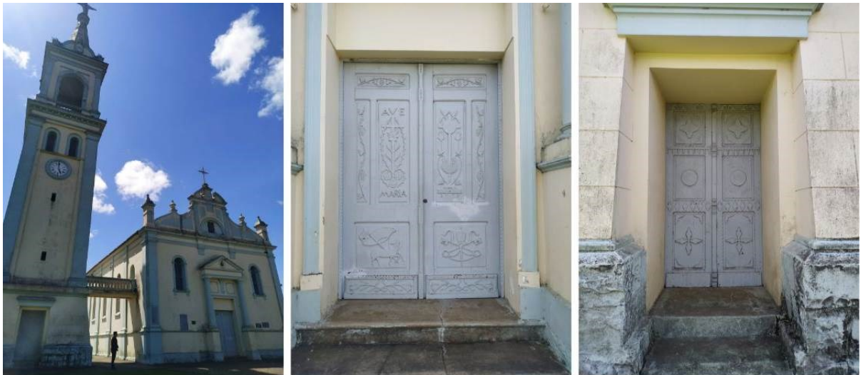
Figura 36 – Conjunto de imagens da fachada e portas externas.
