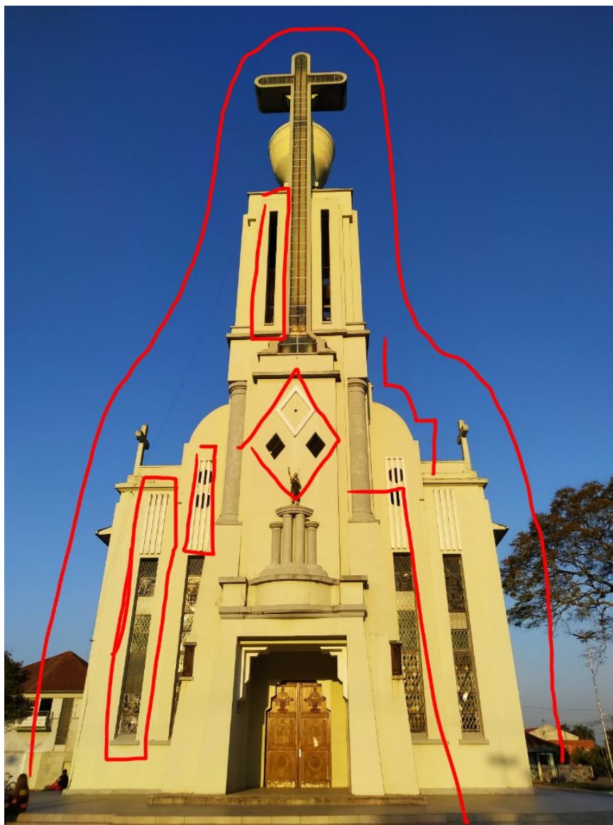
Figura 106 - Análise da fachada da matriz.
