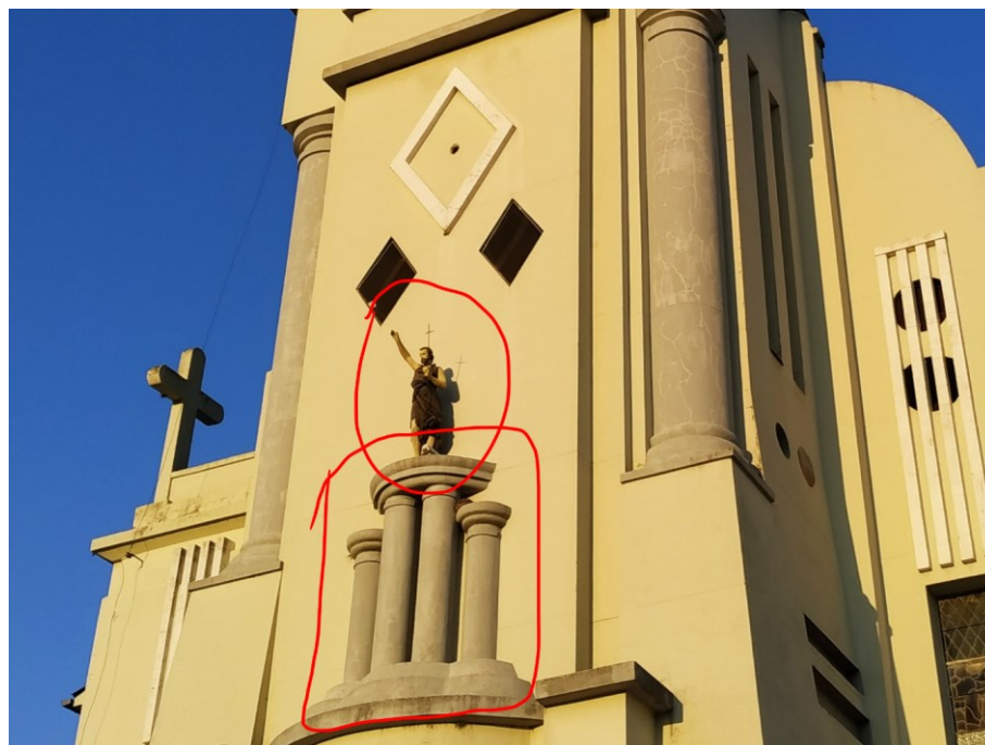
Figura 107 - Análise da fachada da matriz.
