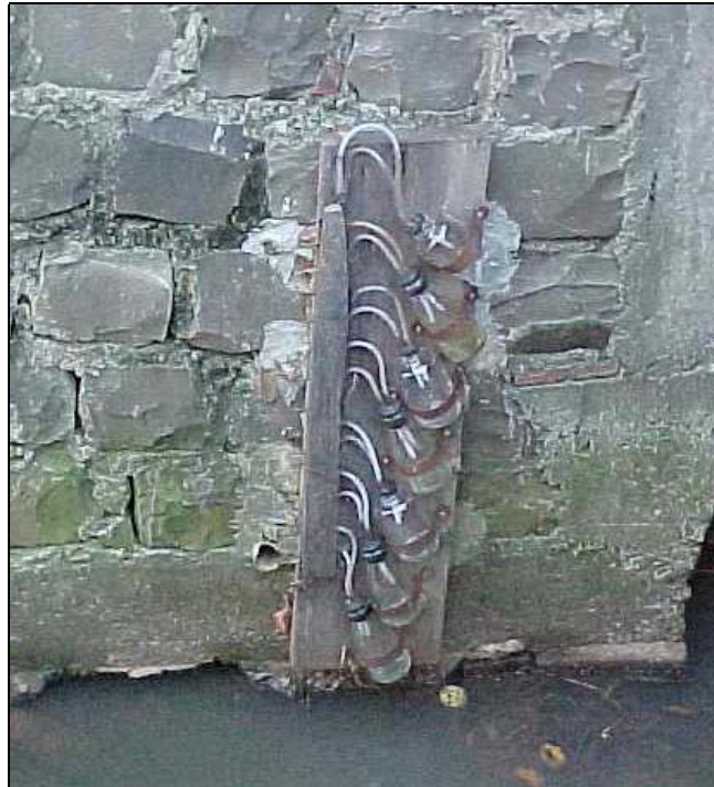
Figura 12: Amostrador de nível ascendente ANA instalado na bacia hidrográfica Alto da Colina.
