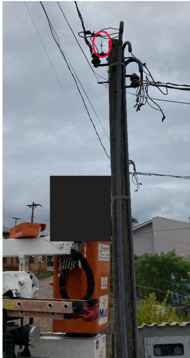
Figura 4.12 – UC2 com a antena externa no topo do poste de entrada de energia.
