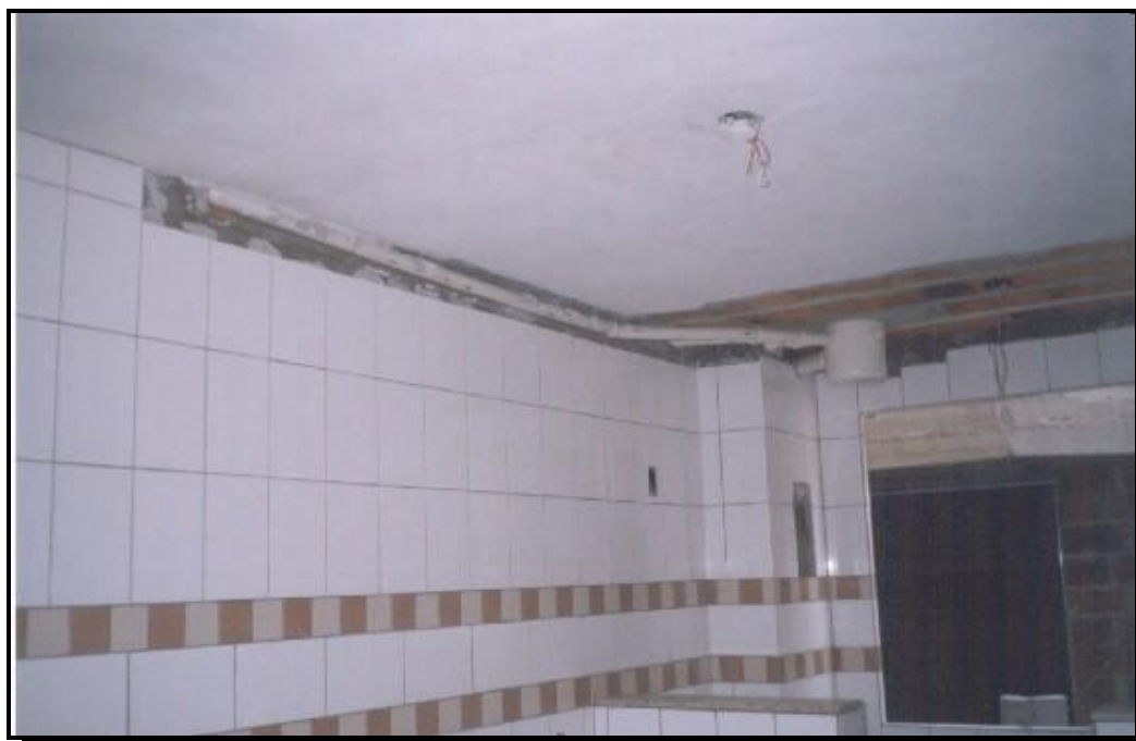
FIGURA 4.43 – Tubulação da cozinha a ser ocultada por sanca de gesso.
