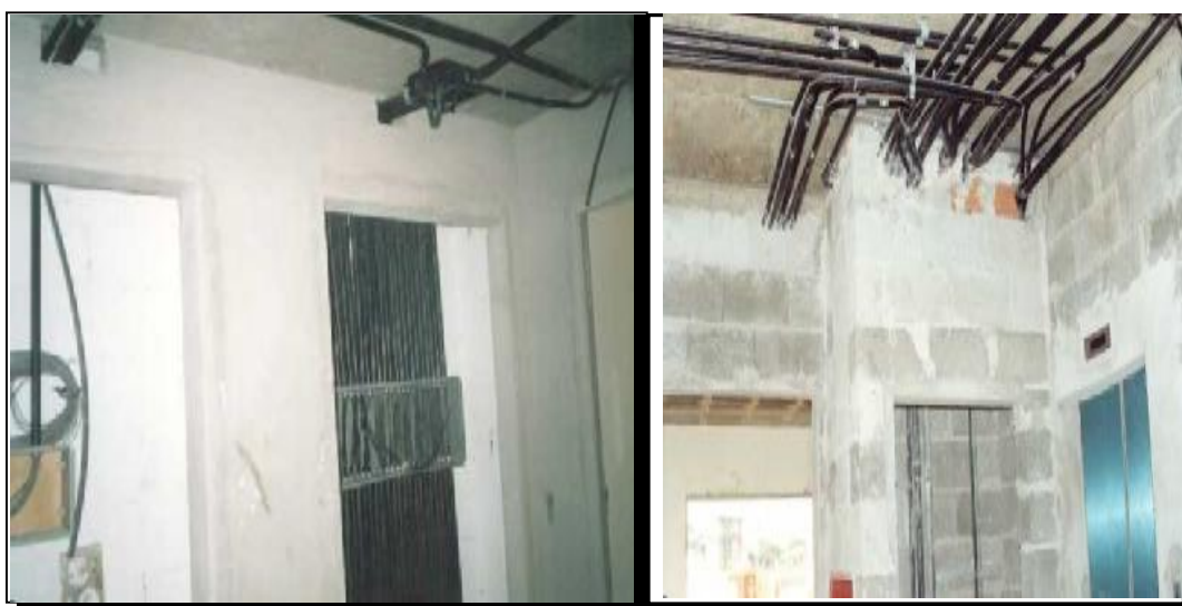
FIGURA 4.16 – Execução de shafts para colunas das instalações elétricas localizados na circulação.
