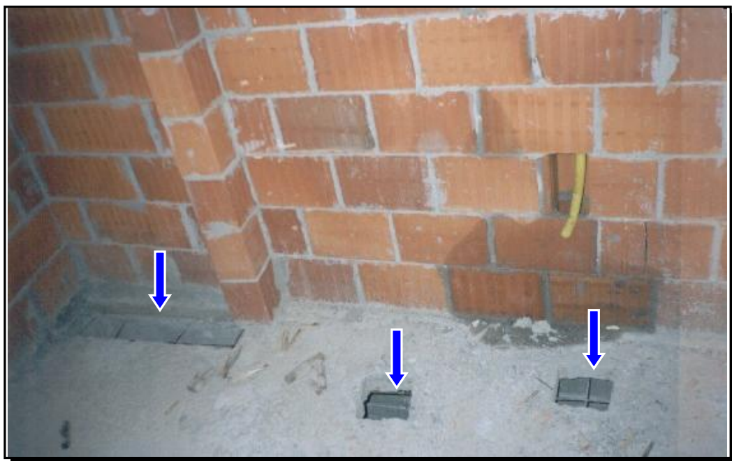
FIGURA 4.41 – Esperas para passagem de tubulações hidrossanitárias deixadas na laje.
