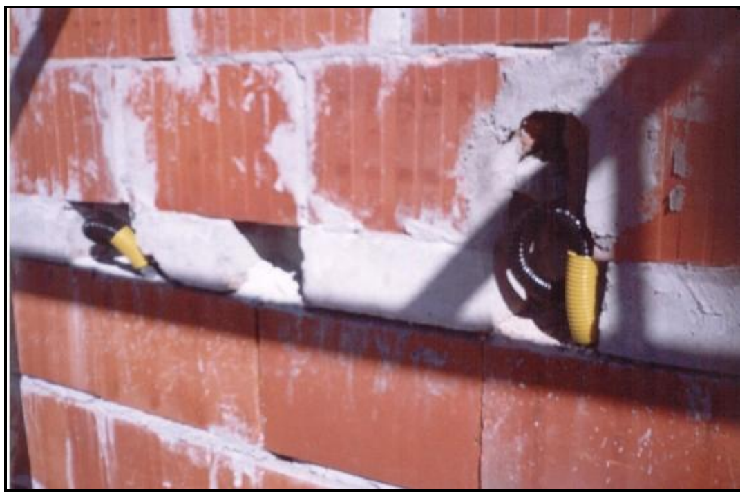
FIGURA 4.47 – Conexão entre eletrodutos da laje pré-moldada e esperas instaladas na alvenaria.
