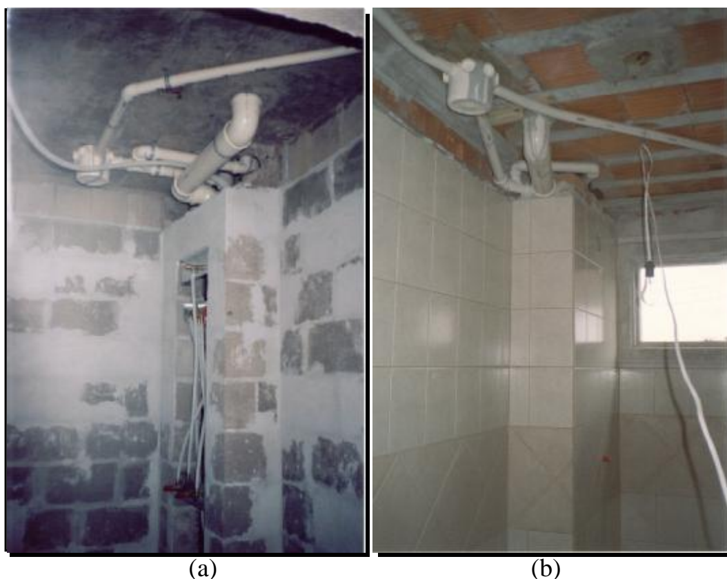
FIGURA 4.26 – Shafts para instalações hidrossanitárias em alvenaria estrutural.
