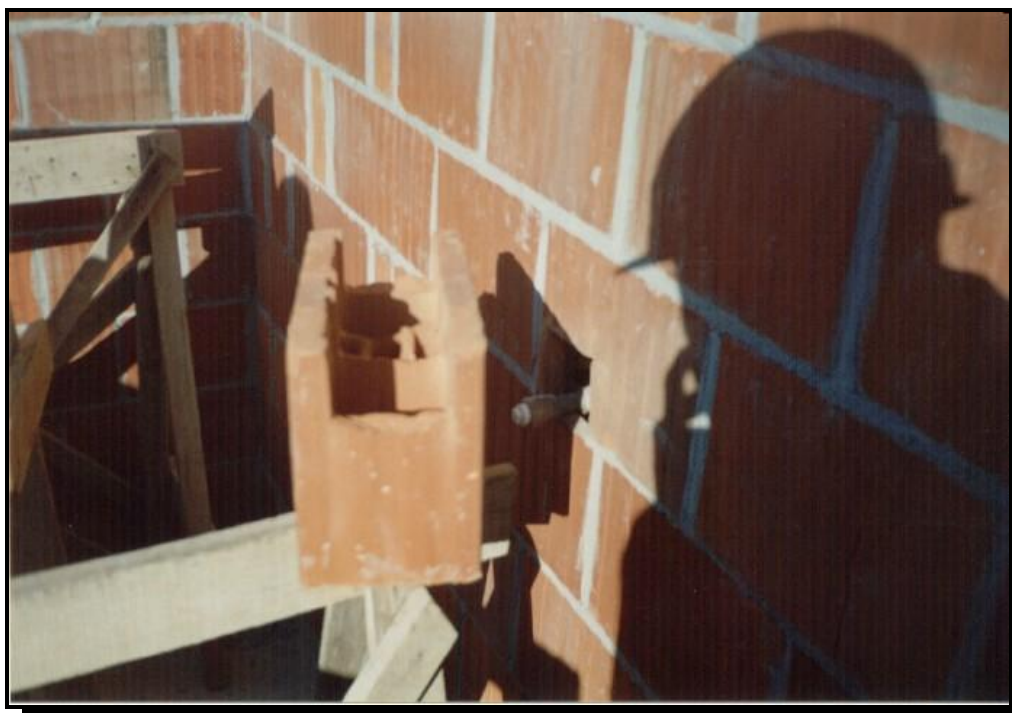
FIGURA 4.39 – Instalações hidrossanitárias horizontais no interior da alvenaria.
