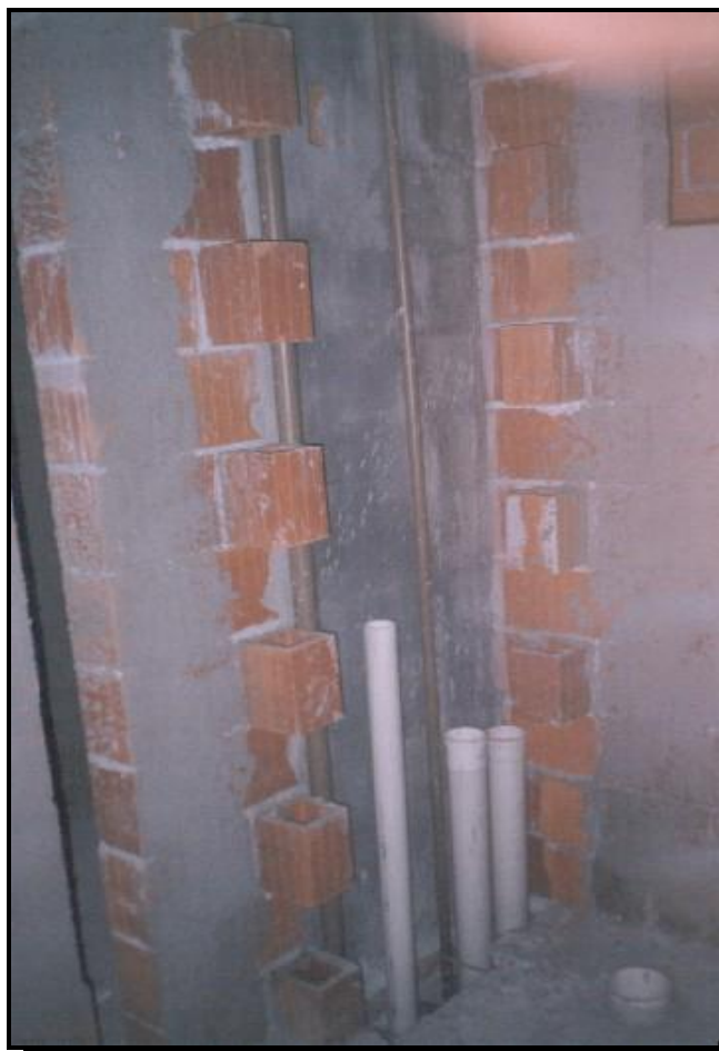
FIGURA 3.6 – Execução de um shaft projetado para instalações hidrossanitárias.
