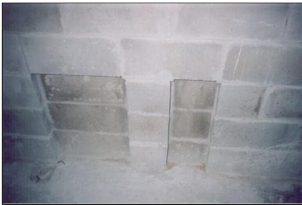
FIGURA 4.24 – Blocos de concreto com 9cm de espessura para instalações hidrossanitárias.
