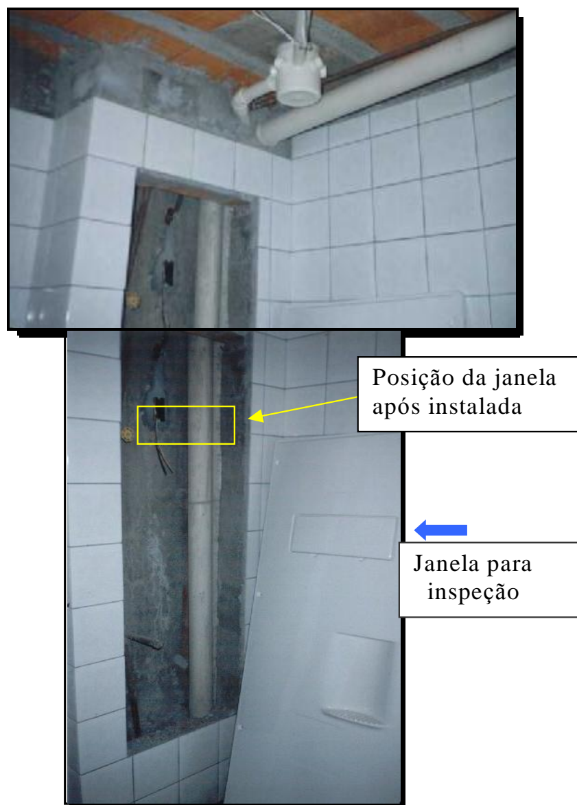
FIGURA 4.27 – Execução de um shaft para instalações hidrossanitárias.
