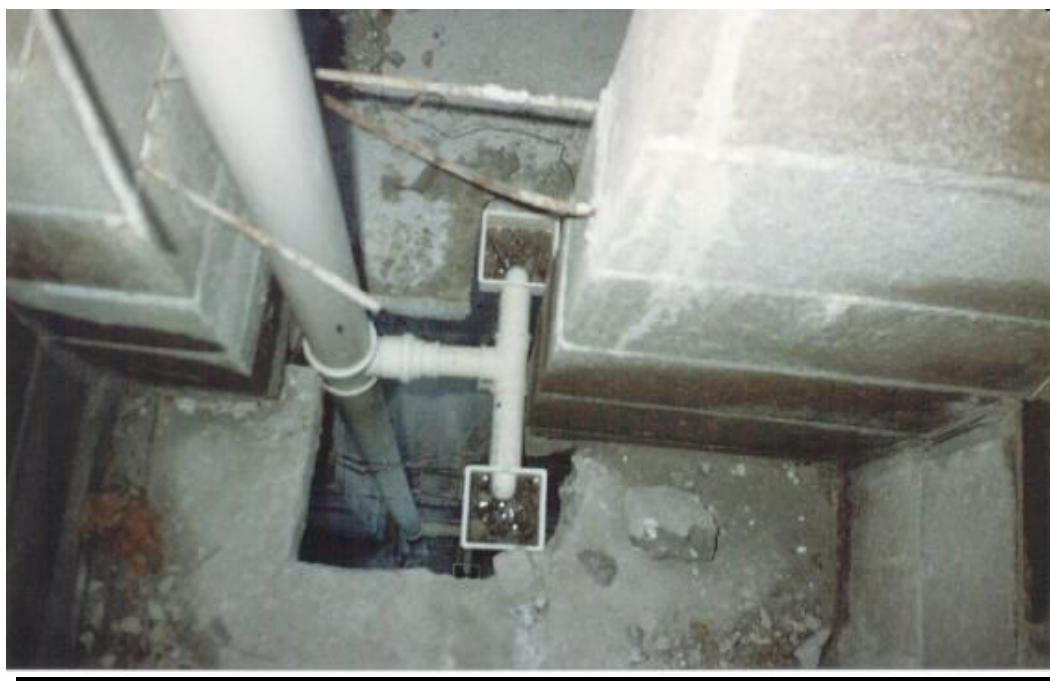
FIGURA 4.44 – Ralos ligados à coluna pluvial localizada na alvenaria de divisa entre duas sacadas.
