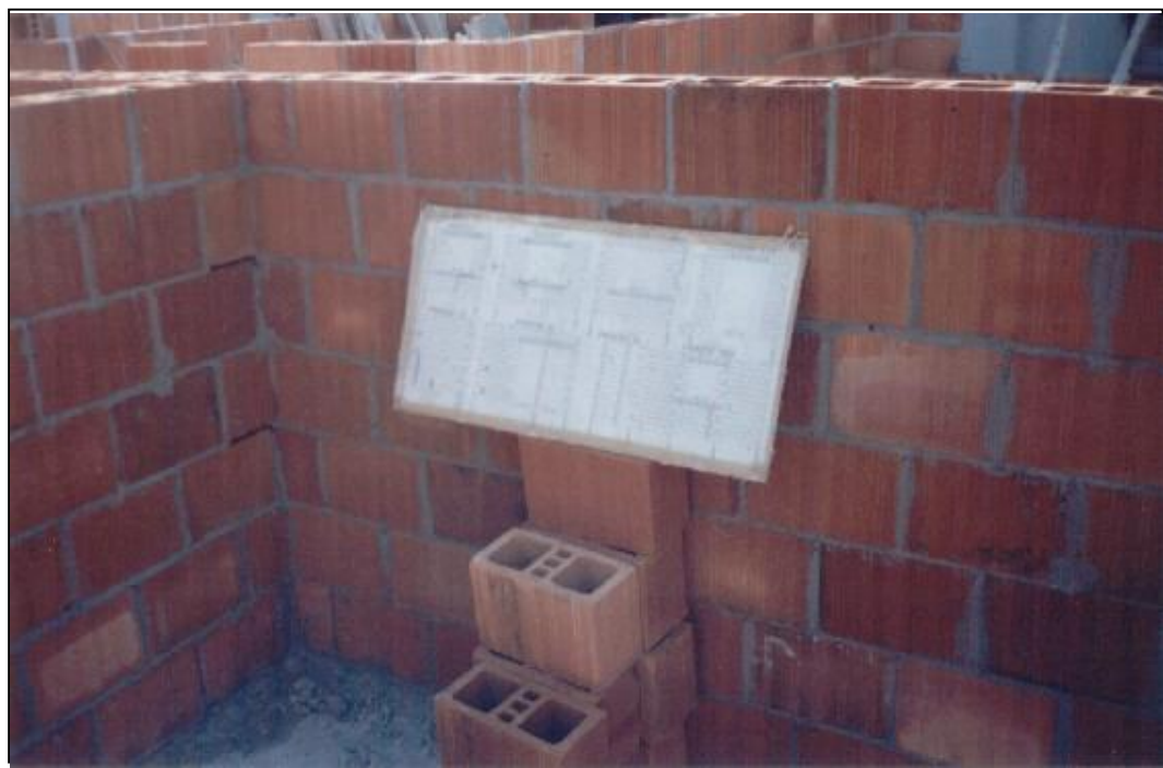
FIGURA 4.1 – Disposição correta de projetos na obra. Prancha plastificada para proteção do projeto.
