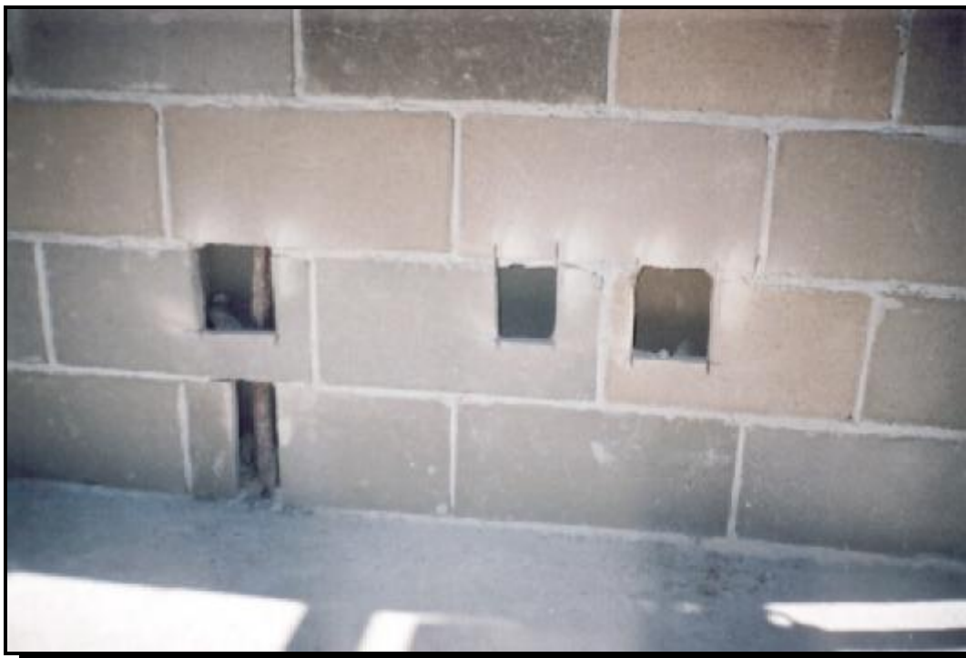
FIGURA 4.8 – Cortes em blocos de concreto para pontos elétricos e telefônicos.
