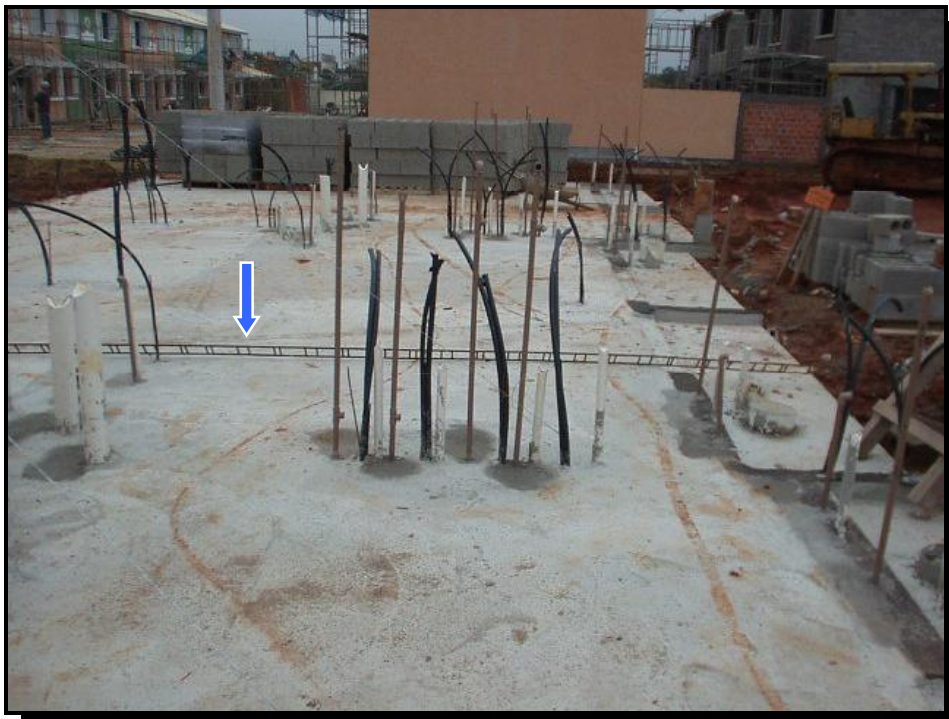
FIGURA 4.33 – Gabarito metálico de modulação e esperas para instalações.
