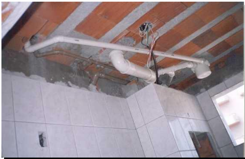
FIGURA 4.42 – Instalações hidrossanitárias horizontais sob a laje, aguardando forro falso para fechamento.
