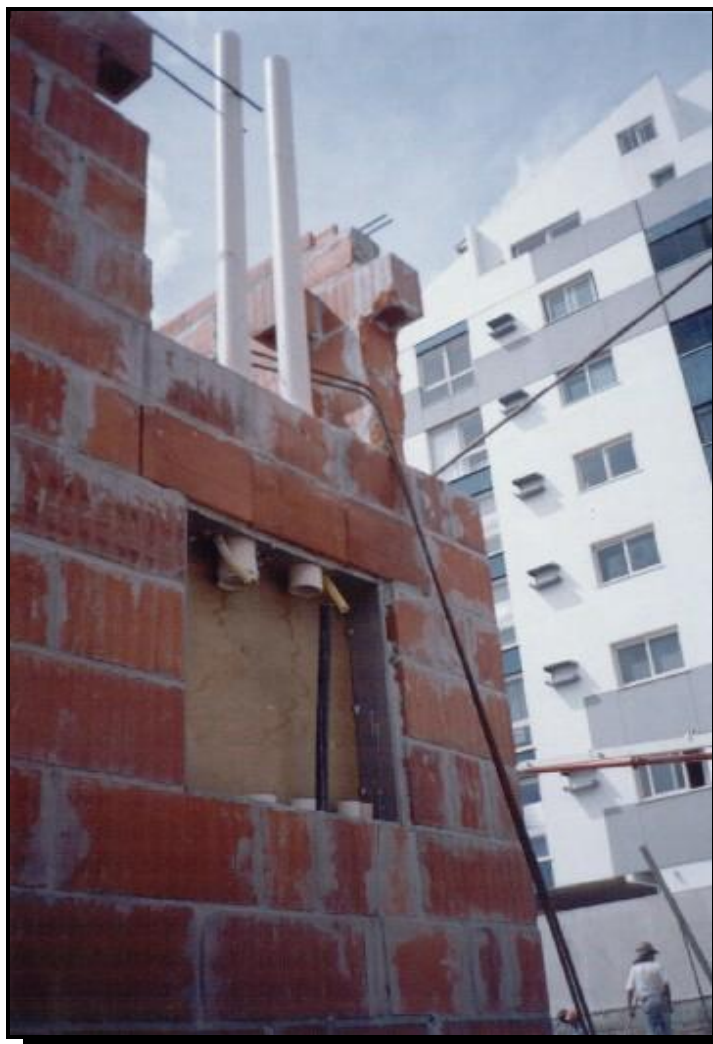
FIGURA 4.17 – Colunas de tubos de PVC para posterior passagem de eletrodutos.
