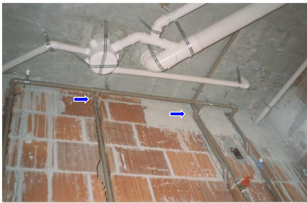
FIGURA 5.3 – Tubulação hidrossanitária instalada abaixo da cinta.
