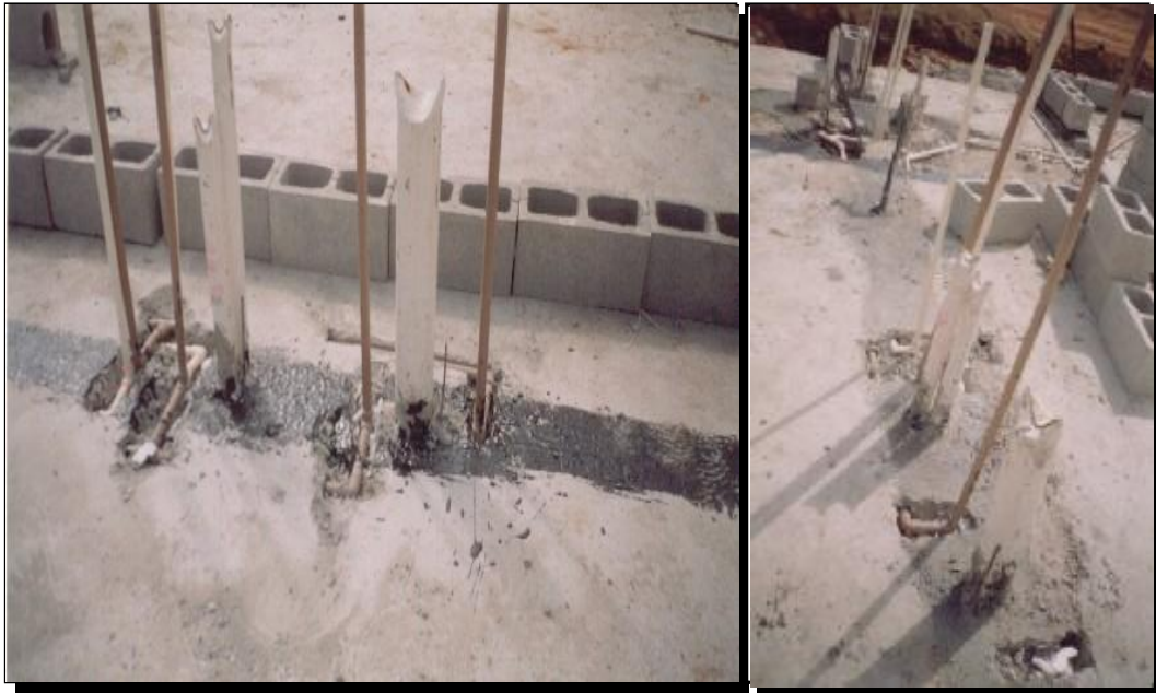
FIGURA 4.32 – Esperas para instalações hidrossanitárias executadas anteriormente ao radier.
