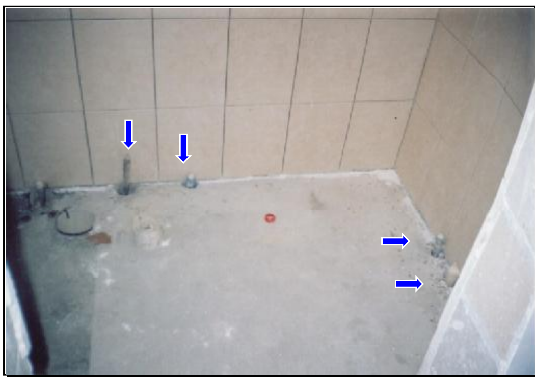
FIGURA 4.35 – Instalações hidrossanitárias executadas externamente às alvenarias.
