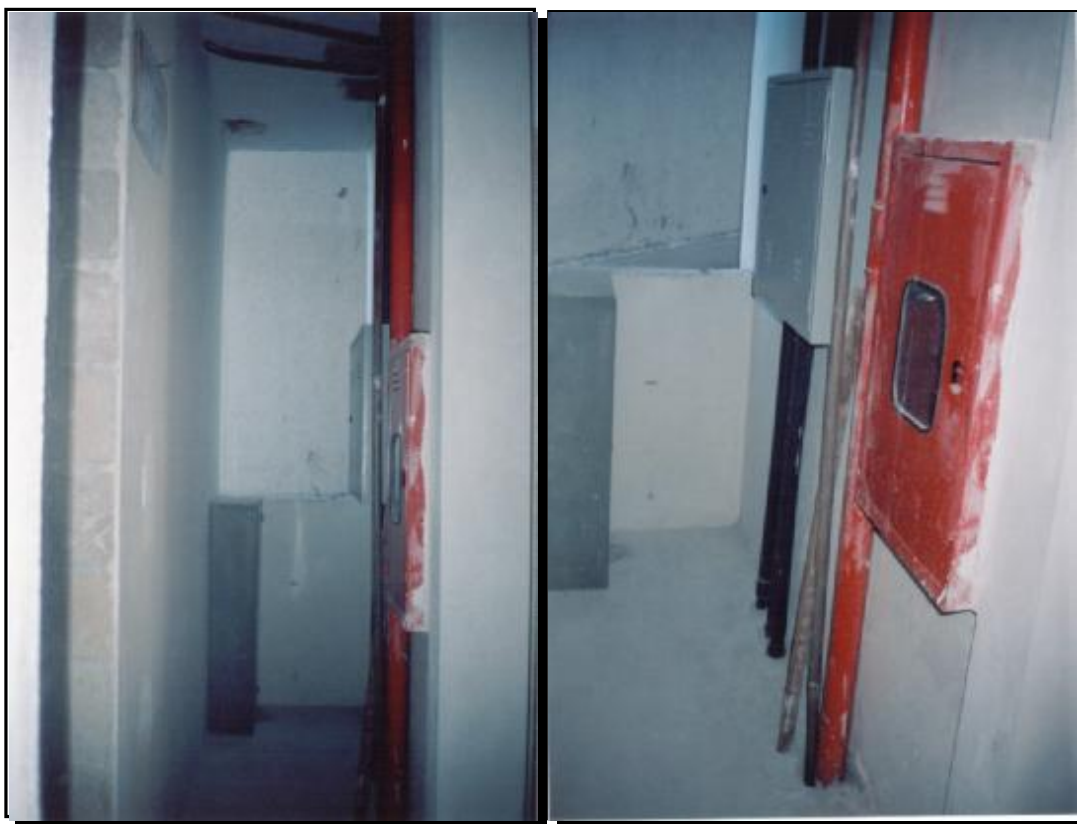
FIGURA 4.15 – Shaft para instalações localizado na circulação, com acesso para pessoas.
