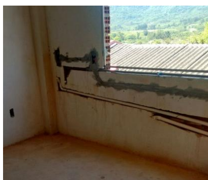
Figura 3: Modificações para cozinha.
