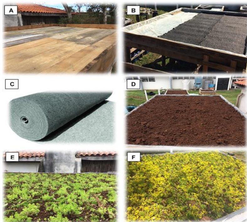
Figura 13 - Processo de construção dos telhados verdes: A – estrutura do telhado; B – impermeabilização e camada de drenagem; C – geocomposto; D – colocação do substrato; E – plantio das mudas; F – vegetação no início do monitoramento.
