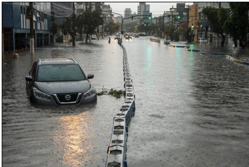
Figura 10 - Alagamento nos entornos do Arroio Dilúvio em 2022.
