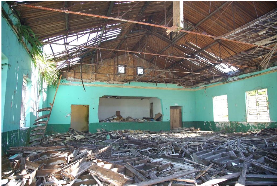
Figura 29 – Antigo Clube dos Ferroviários - Interior.
