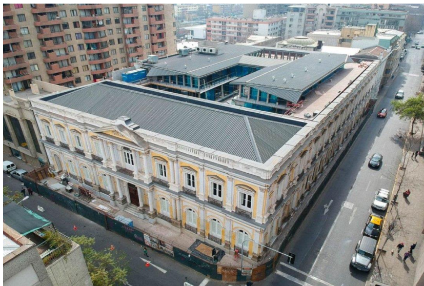
Figura 18 – Vista aérea do Palácio após as intervenções.
