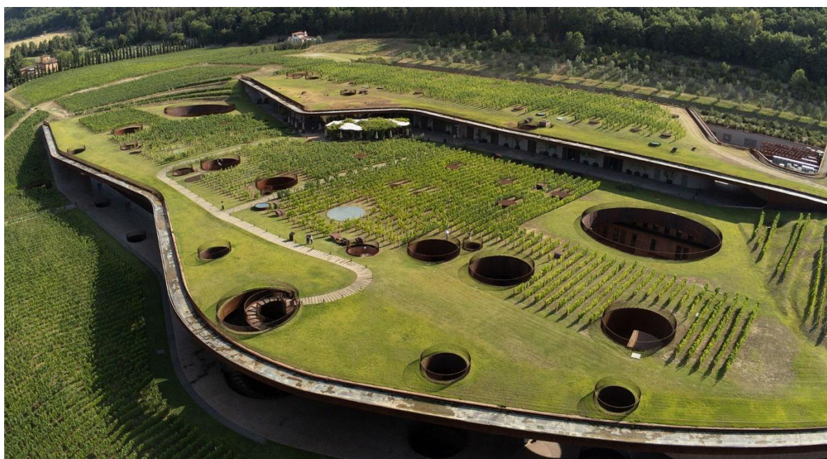
Figura 14: Imagem da cobertura da vinícola.
