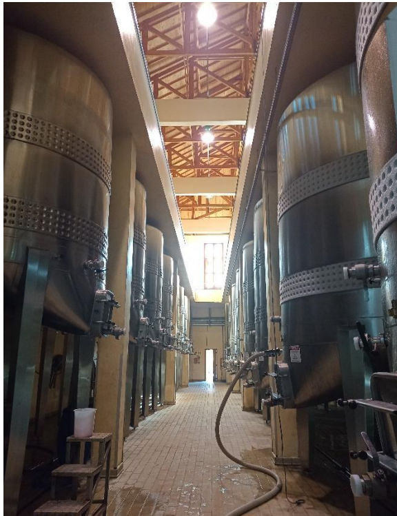
Figura 41: Tanques de fermentação visual da parte de baixo.
