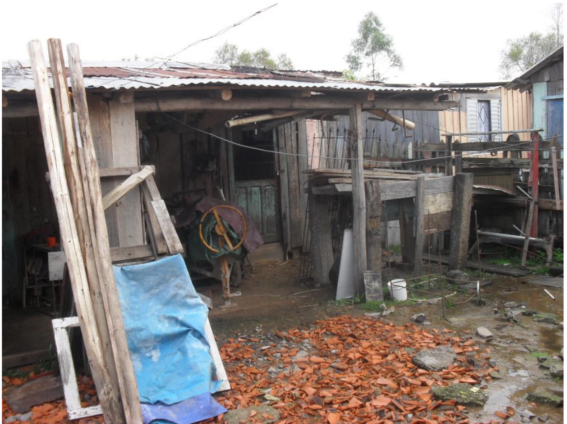
Figura 3 – Vista parcial do final do terreno das casas no Loteamento Brenner
