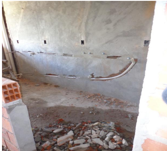
Figura 58– Parede rebocada e recortada
