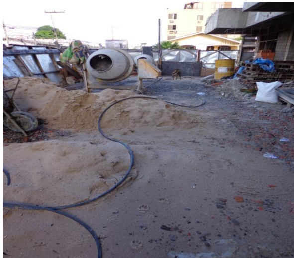
Figura 19– Sem baias para os agregados
