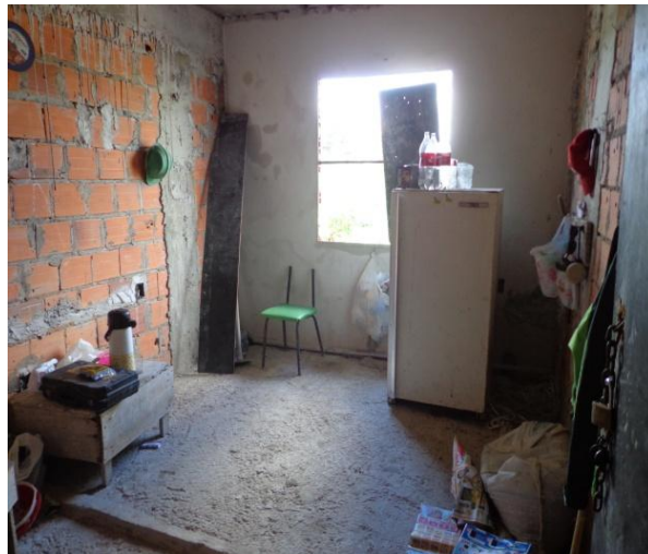
Figura 49– Instalações do refeitório
