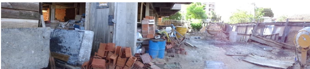
Figura 8– Primeira vista do canteiro de obras
