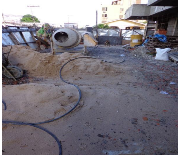
Figura 31– Agregados misturados
