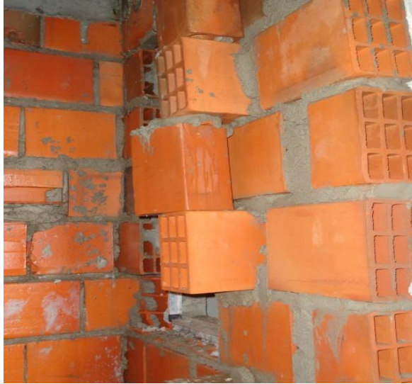
Figura 60– Tijolos mau assentados
