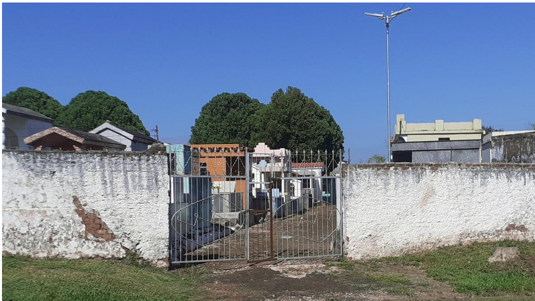
Figura 10 – Portão 2, entrada lateral
