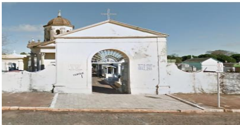
Figura 8 – Entrada principal do cemitério
