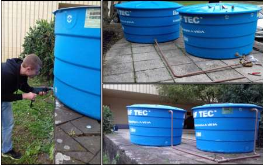
Figura 5 - Instalação do sistema de recalque da água bruta
