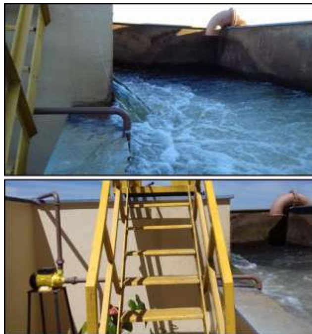
Figura 5 - Instalação do sistema de recalque da água bruta
