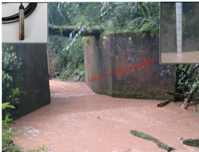
Figura 24 - Calha Parshall no exutório da bacia.
