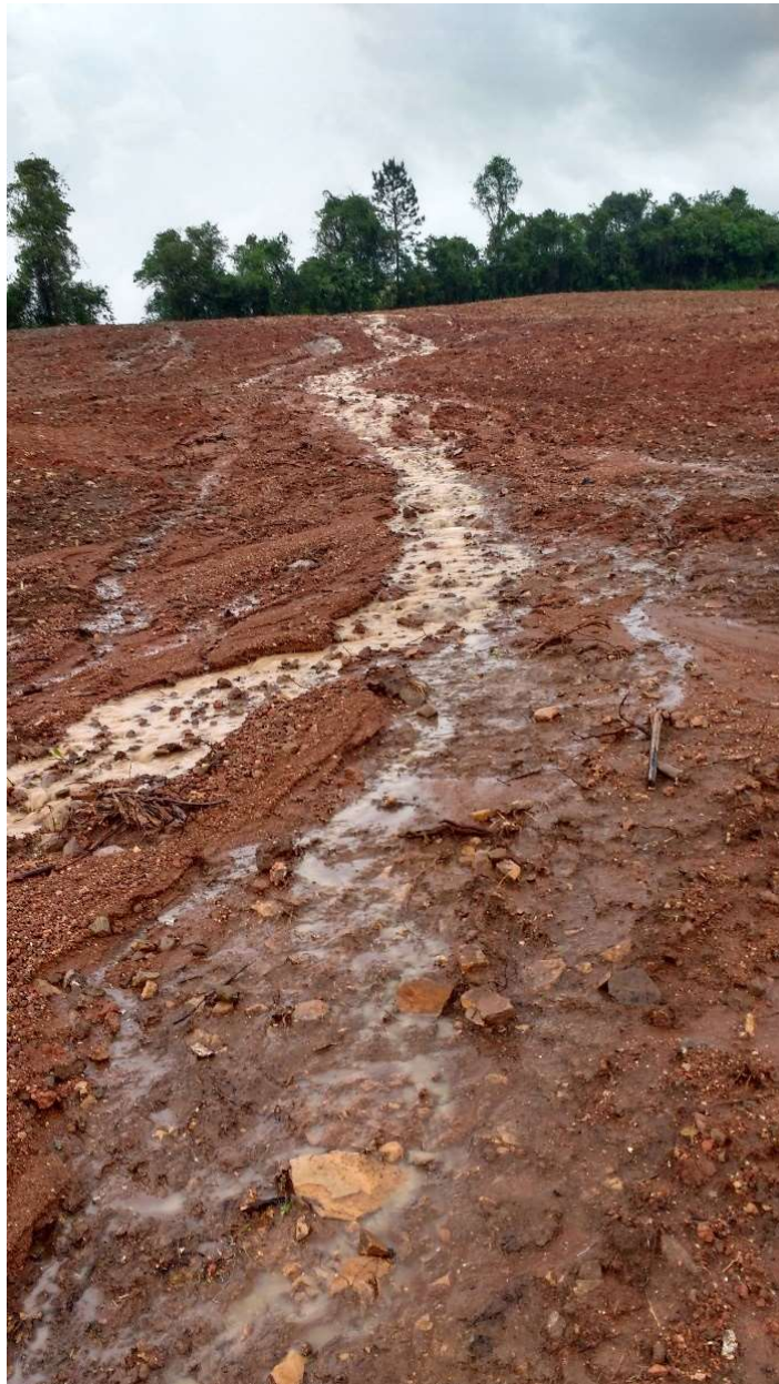
Figura 11 Encosta sob efeito de erosão entresulcos e em sulcos
