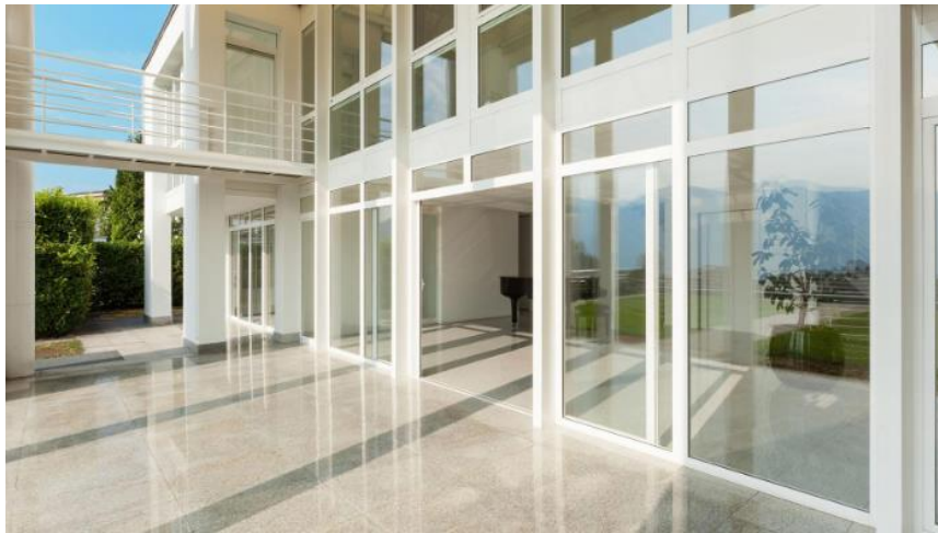
Figura 12: Esquadrias de PVC
