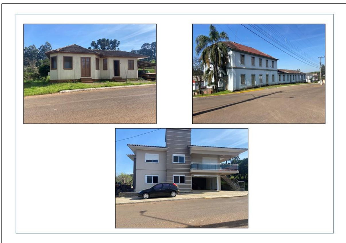
Figura 22 – Construções em União da Serra
