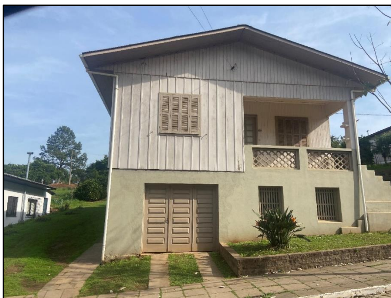
Fotografia 9 – Casa que mantém a estrutura colonial de construção em Nova Araçá/RS
