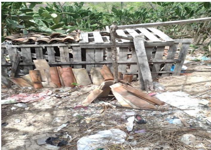
Foto 791 – Chiqueiro dos porcos reformado, mas com instalações precárias
