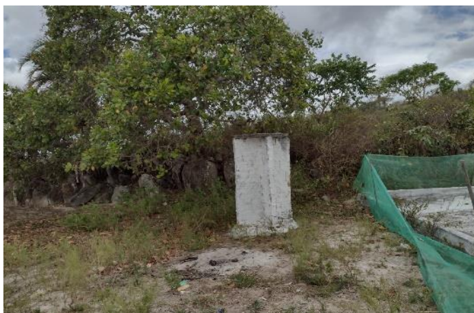
Foto 71 – Parte do calçadão com a tela para evitar a entrada de animais
