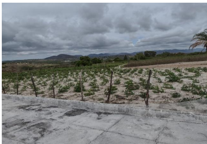
Foto 60 – Parte do calçadão próximo a uma roça de macaxeira
