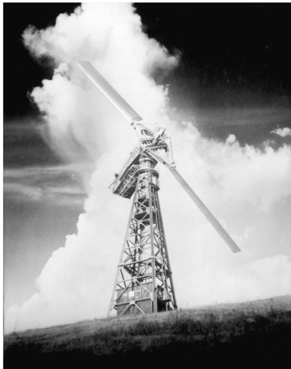
Figura 3 – Primeira turbina na escala de megawatt
