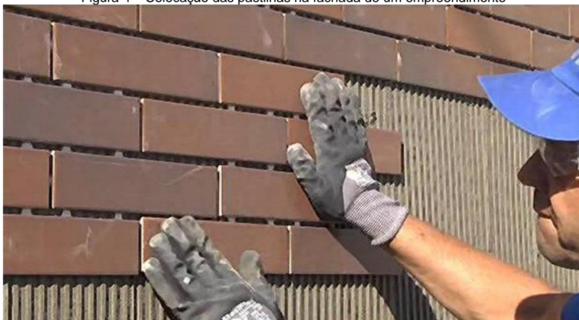
Figura 4 – Colocação das pastilhas na fachada de um empreendimento
