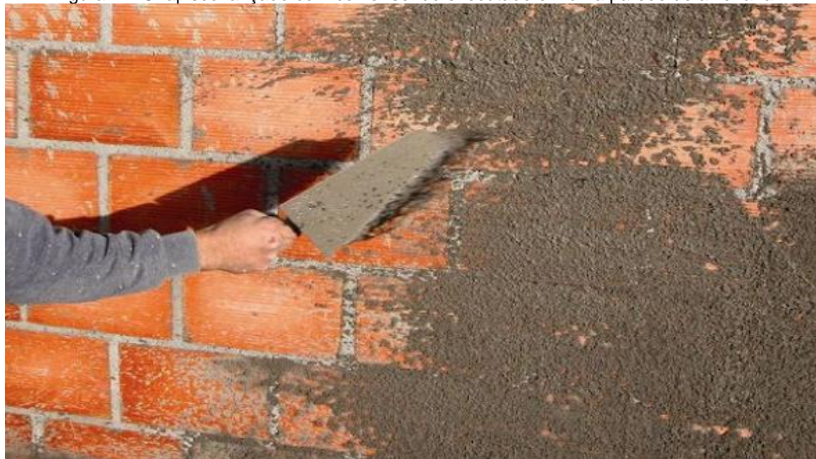
Figura 1 – Chapisco lançado com colher sendo executado em uma parede de alvenaria
