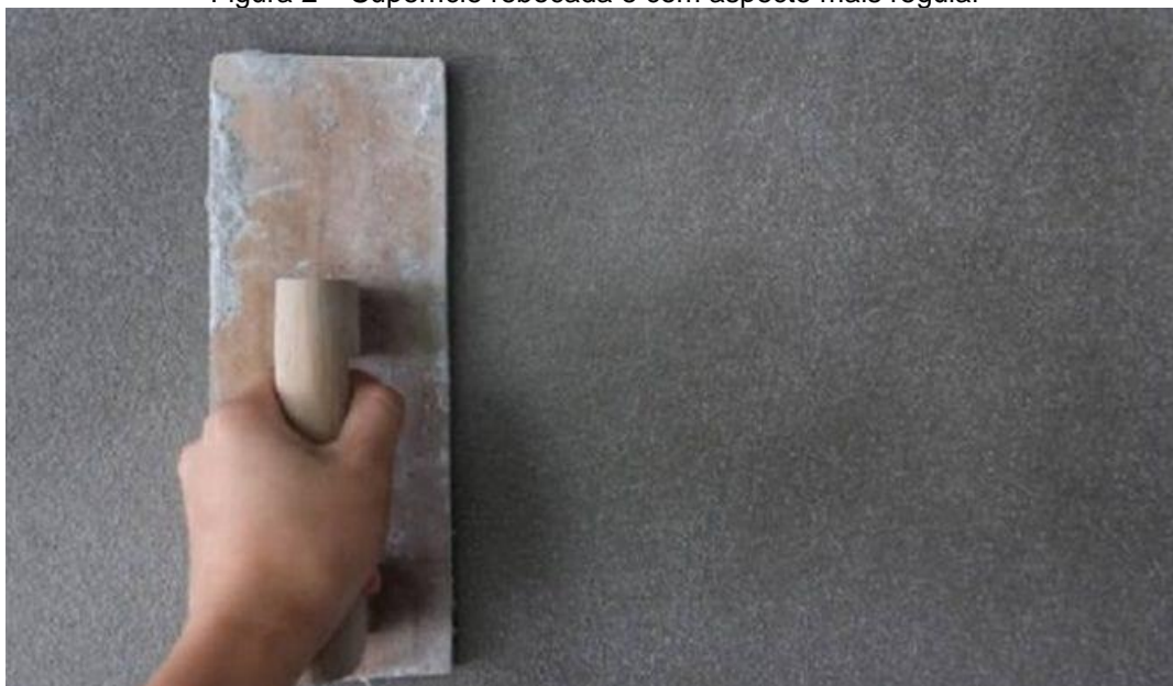
Figura 2 – Superfície rebocada e com aspecto mais regular
