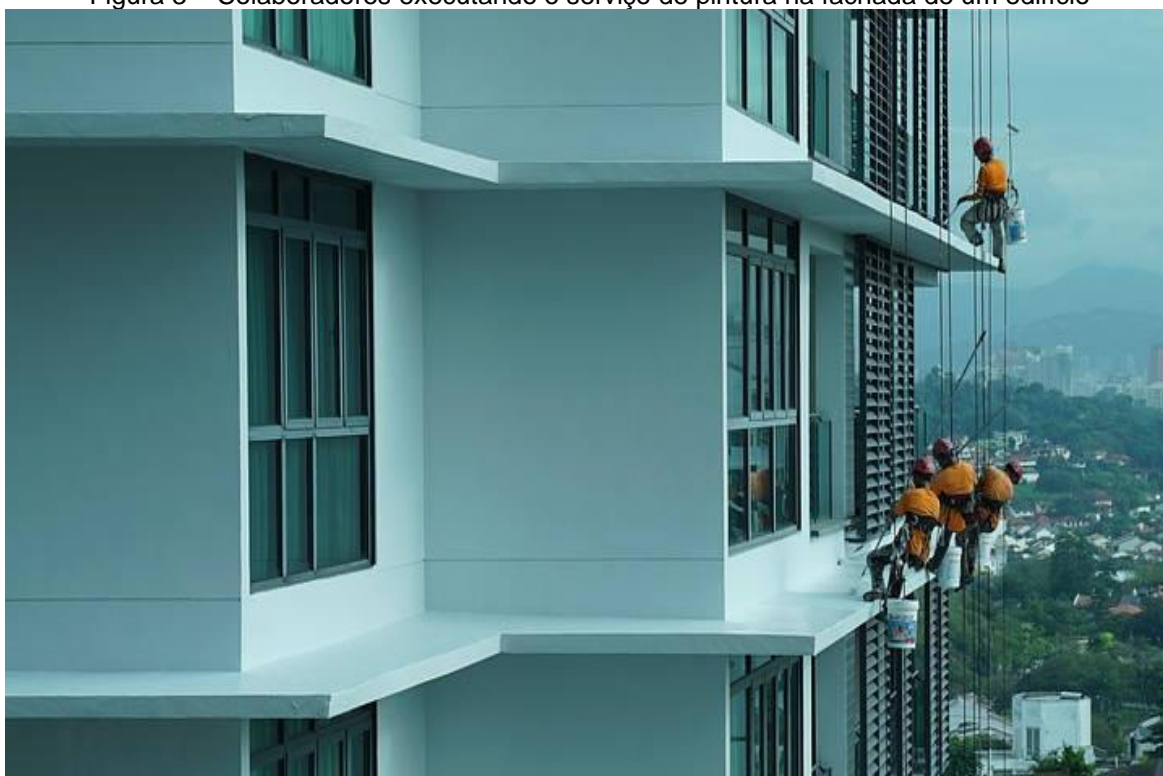
Figura 3 – Colaboradores executando o serviço de pintura na fachada de um edifício
