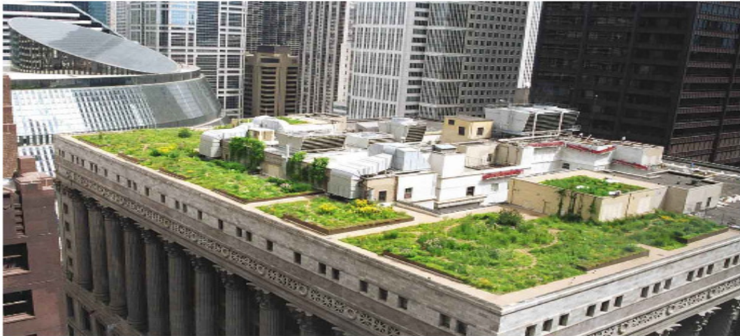
Figura 3 – Telhado verde intensivo na Câmara Municipal de Chicago, Ilinoís, USA. Fonte: Roof Portland (2010).
