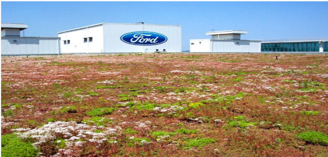
Figura 2 – Telhado verde extensivo com 42100m 2 , instalado na empresa The Ford Motor Company, em Dearborn, Michigan, USA.
