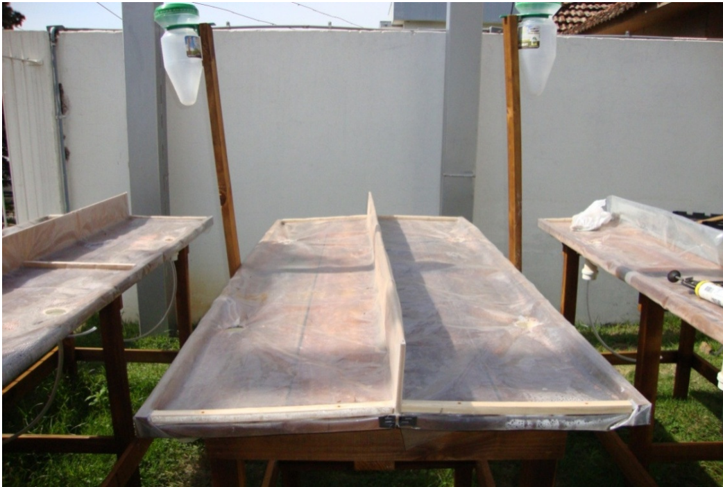
Figura 11 - Vista das bancadas impermeabilizadas.
