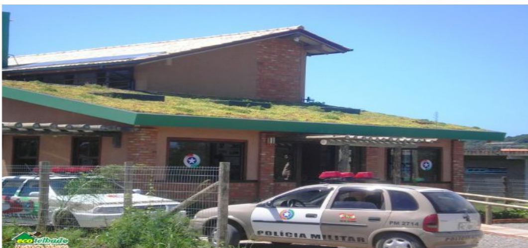
Figura 5 –Telhado verde instalado em posto policial na Praia do Rosa - Imbituba – SC, Brasil. Fonte: Ecotelhado (2010).
