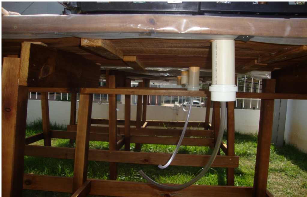
Figura 12 - Sistemas de drenos das bancadas.
