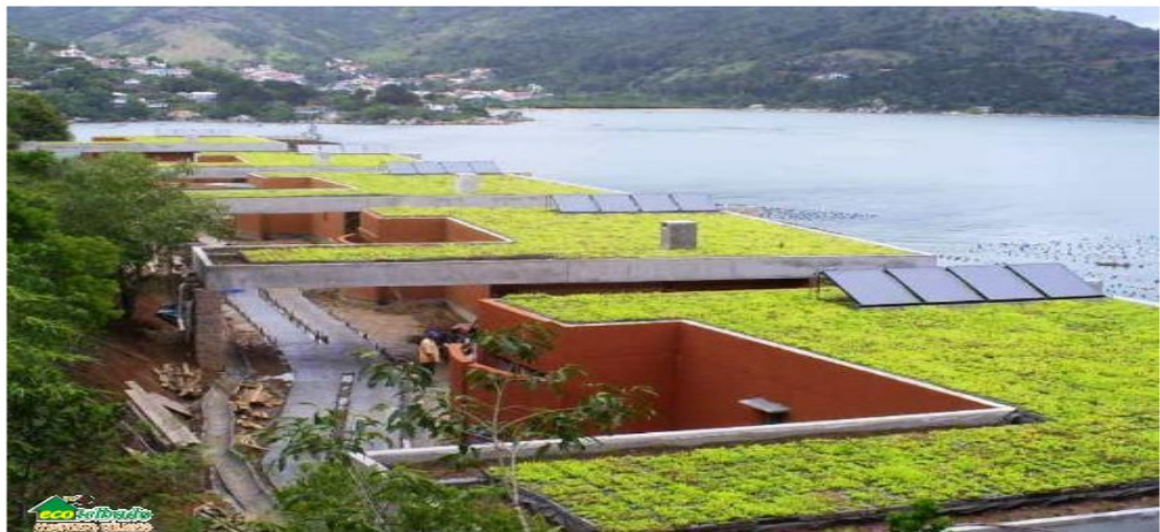
Figura 4–Telhado verde instalado em casas, em Ganchos – SC, Brasil. Fonte: Ecotelhado (2010).
